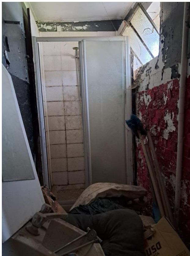
SERVIZIO IGIENICO PIANO TERRA
