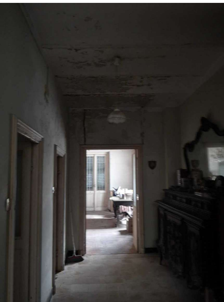
Disimpegno bagno e cucina, in fondo il soggiorno
