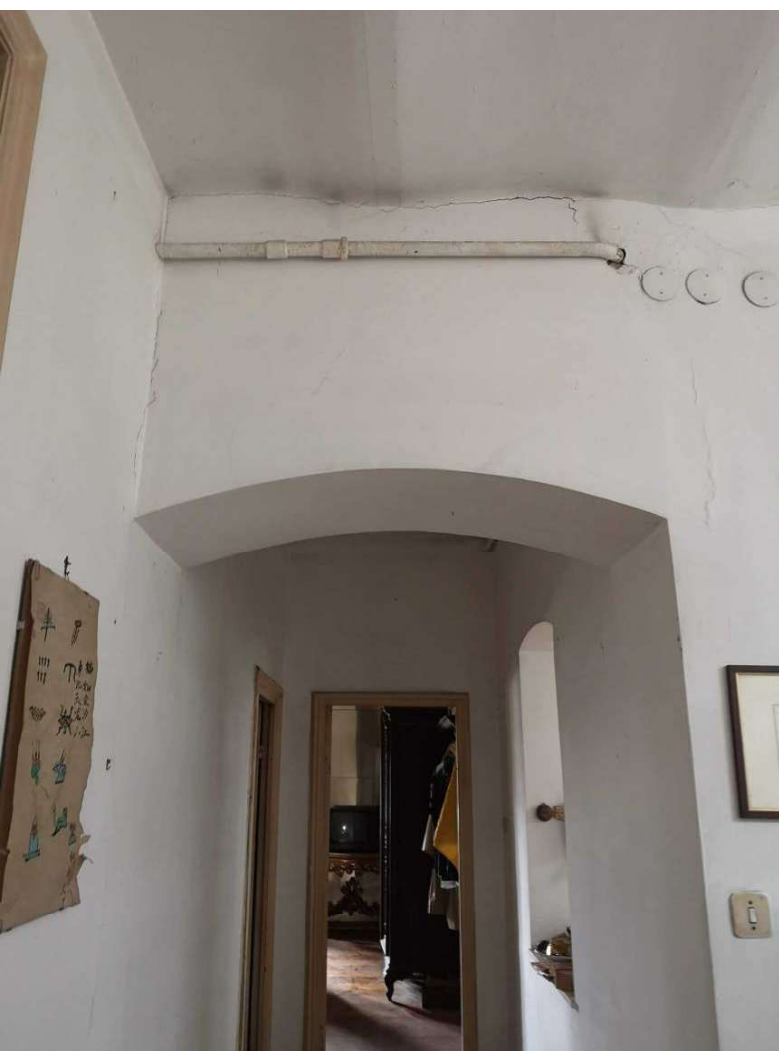
Dal primo disimpegno verso le camere
