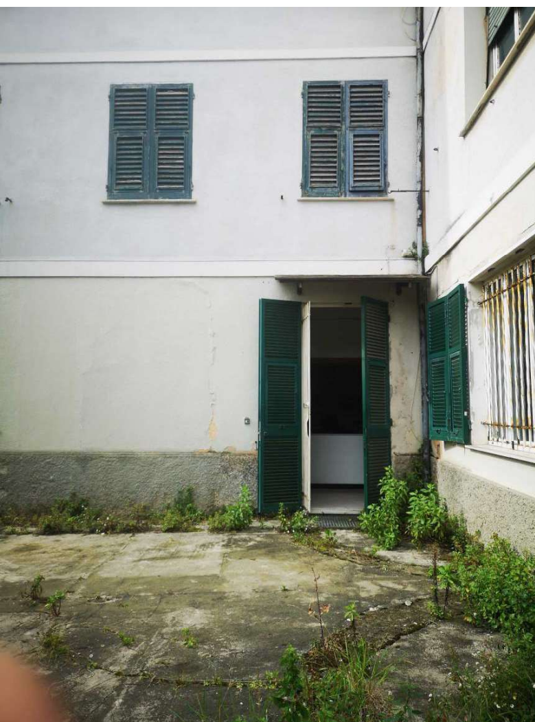
Ingresso int. 1 dall' area di manovra sub 5
