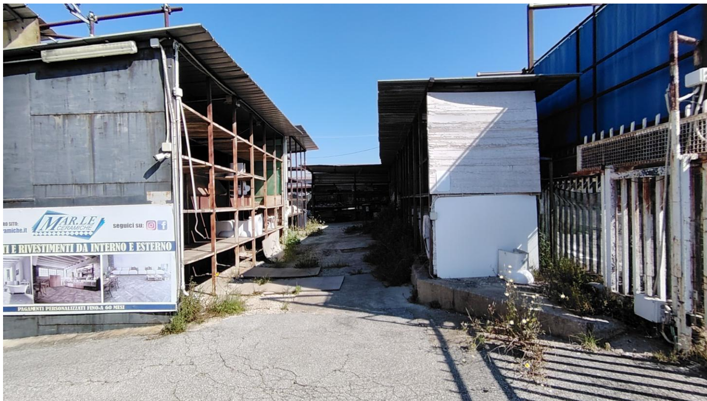
FOTO 2 – ZONA DEPOSITO LATO EST
