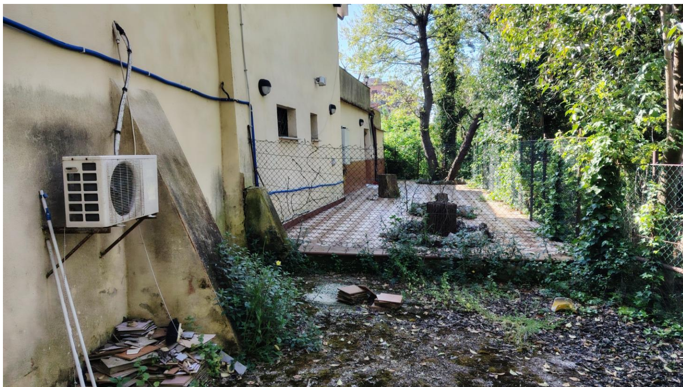
FOTO 3 – TERRAZZO ESTERNO LATO OVEST
