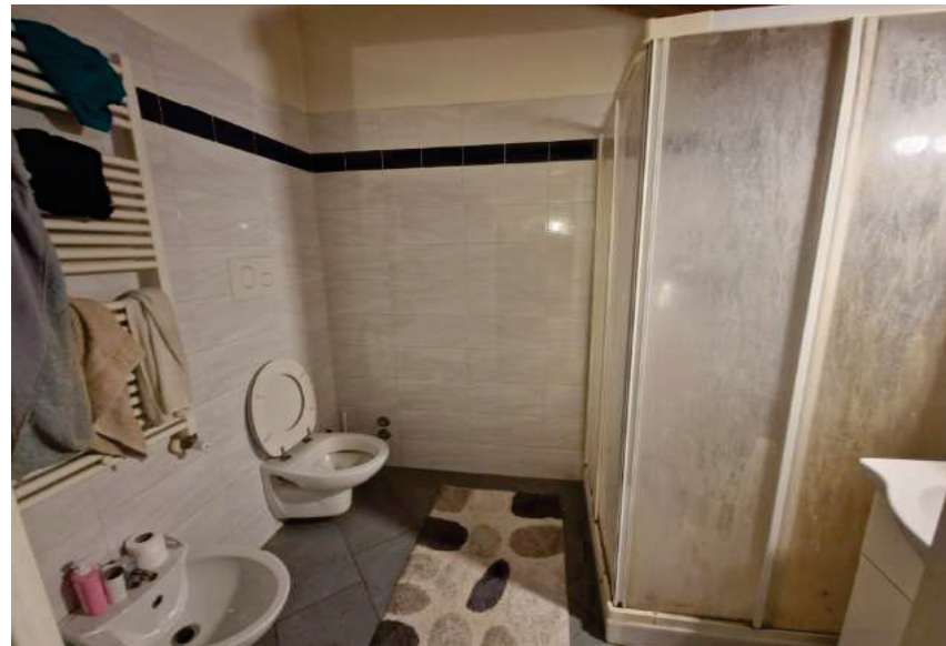
8 - bagno al piano secondo
