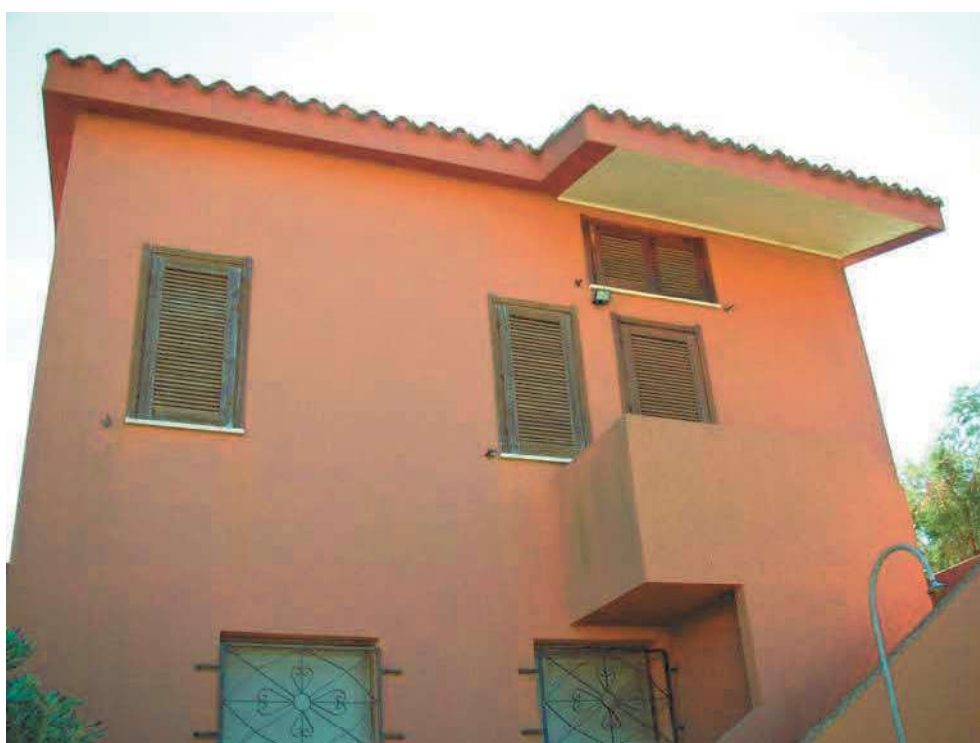
Foto n. 2 – Particolare facciata piano primo
