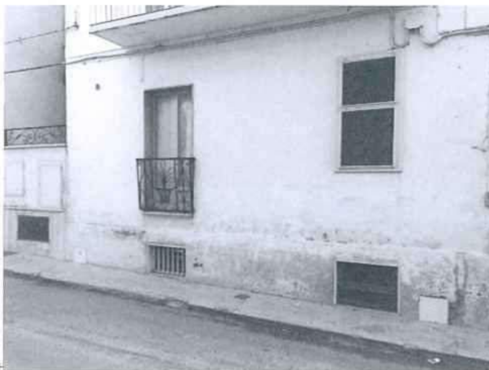
Foto 1 – Facciata su Via Torre di Lupo
