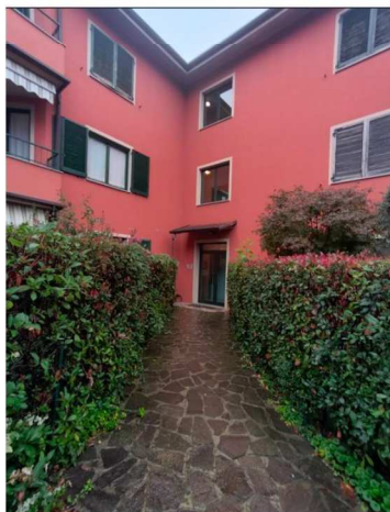
Ingresso alla palazzina
