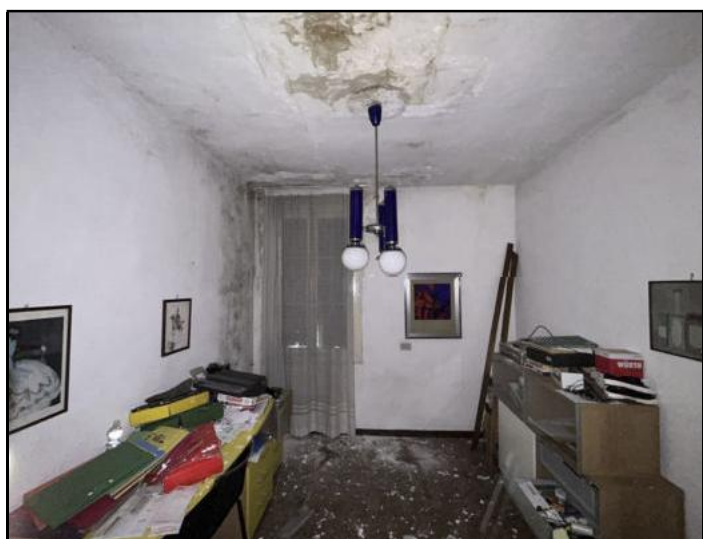
Camera centrale lato nord ovest
