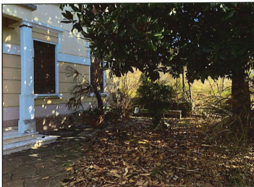
Accesso con gradini dal mapp. 654 al mapp. 653
