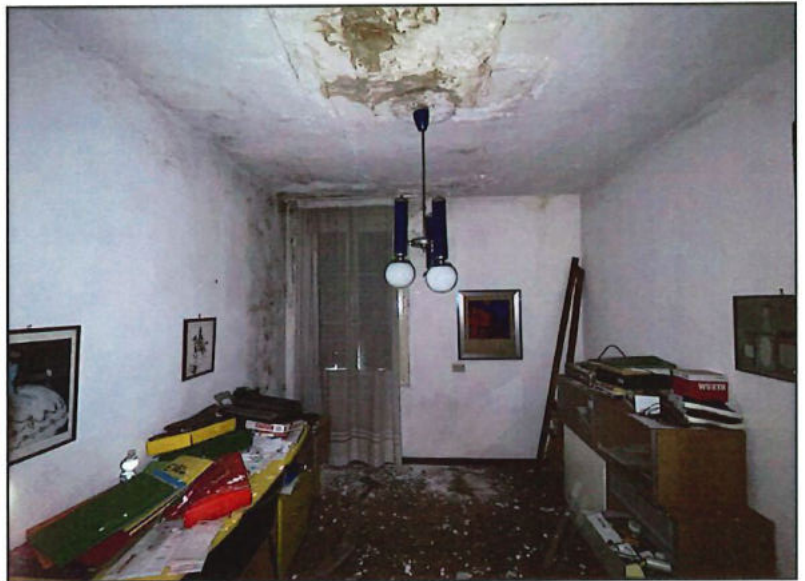
Camera centrale lato nord ovest
