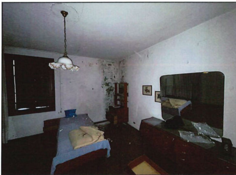
Camera lato sud ovest
