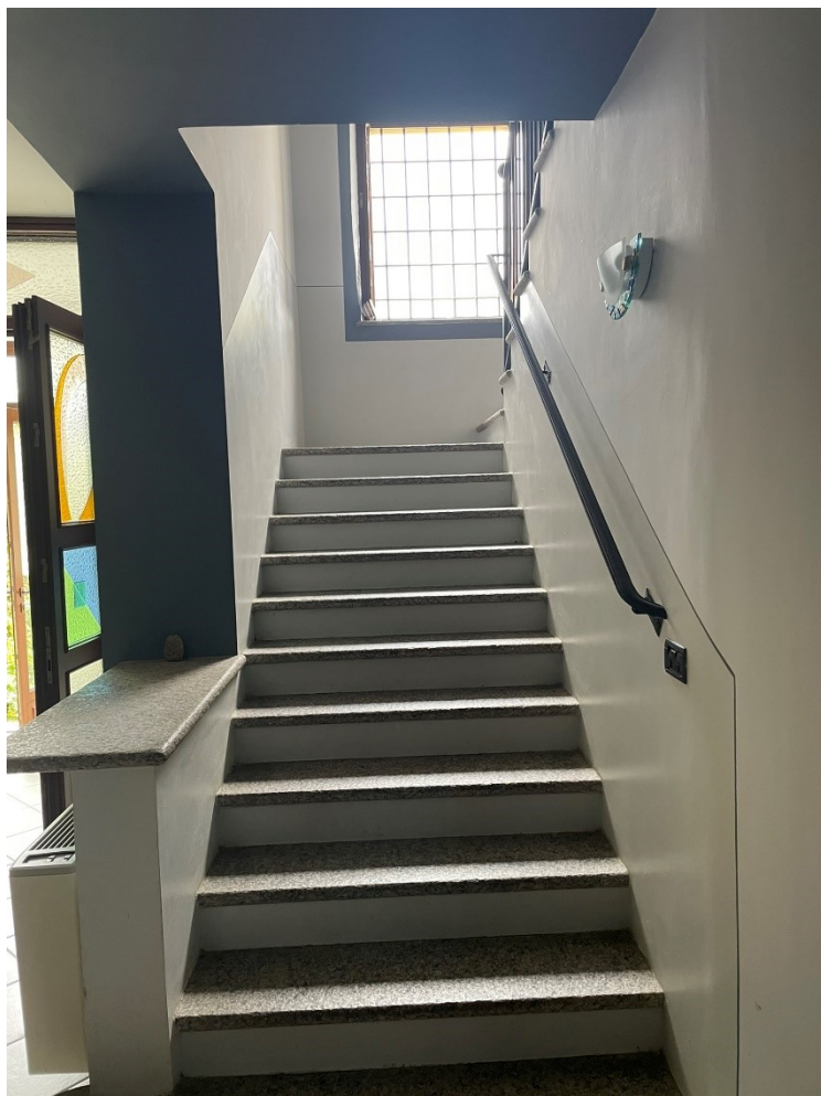
SCALA DI ACCESSO AL PIANO PRIMO
