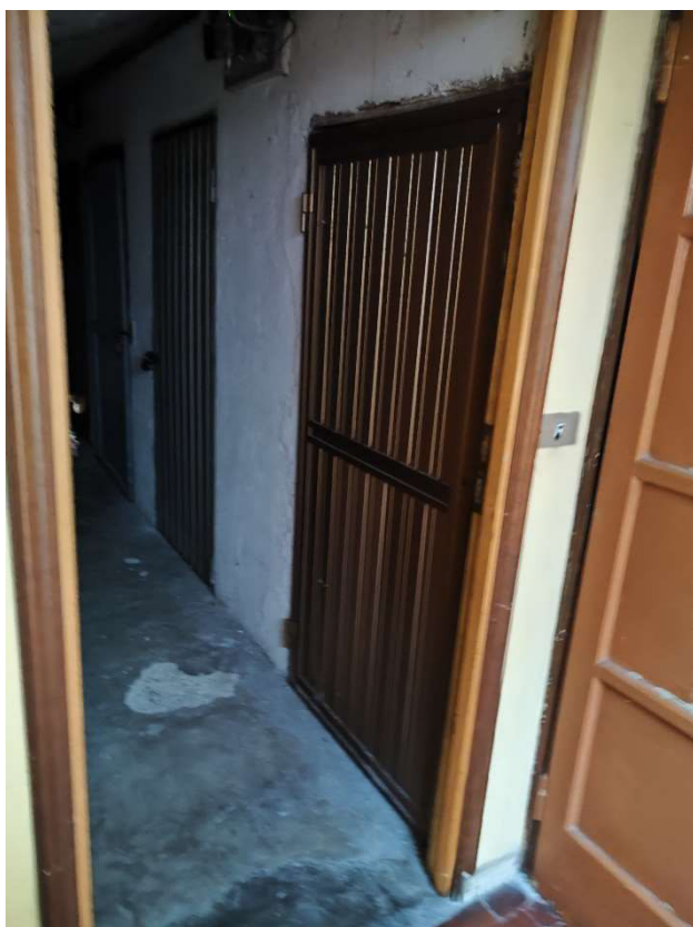
Foto n. 12 – Ingresso alla soffitta
