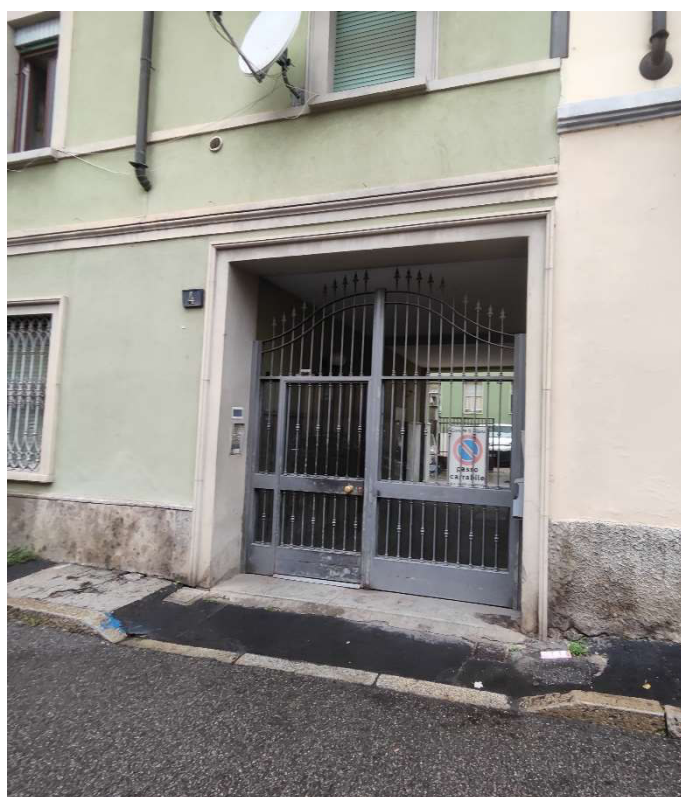
Foto n. 2 – Ingresso al condominio
