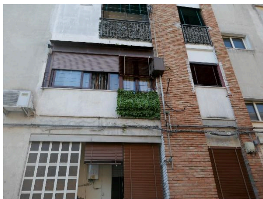
VISTA ESTERNA LAVANDERIA
