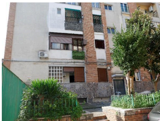
DETTAGLIO FRONTE NORD
