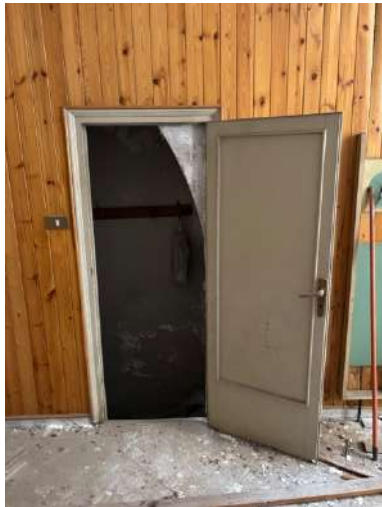
foto n. 8: porta che immette nella scala
