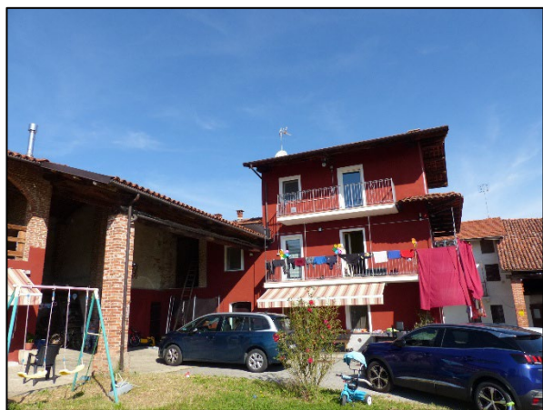
Fotografia n. 1 - Facciata principale lato sud del 329 sub 1— ripresa dal cortile n. 367.
