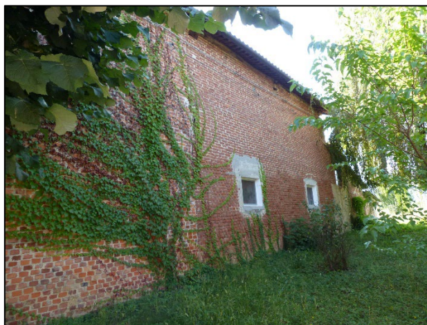
Fotografia n. 6 - Altra ripresa lato ovest del fabbricato 329 sub 2.
