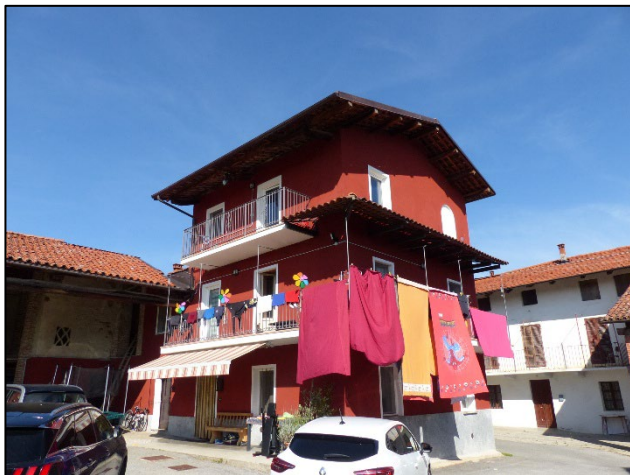
Fotografia n. 3 - Altra ripresa di 2/4 della porzione n. 329 sub 1.
