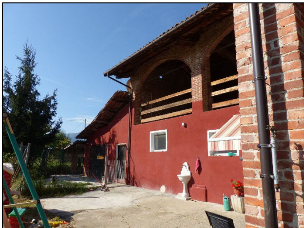
Fotografia n. 27 - Locale ad uso deposito (329 sub 2).
