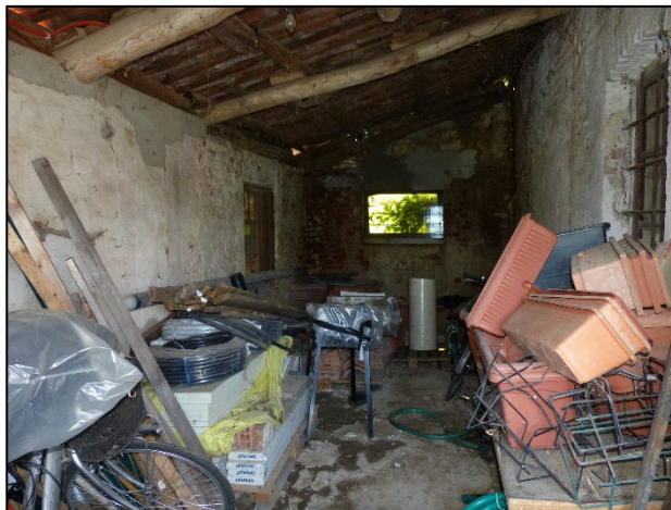
Fotografia n. 28 - Interno del locale deposito centrale al piano terreno (329 sub 2).
