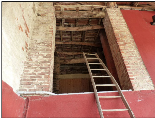
Fotografia n. 20 - Solaio al piano primo (329 sub 1).
