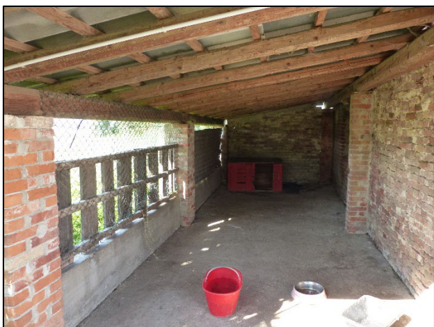
Fotografia n. 29 - Locale ad uso deposito lato sud (329 sub 2).
