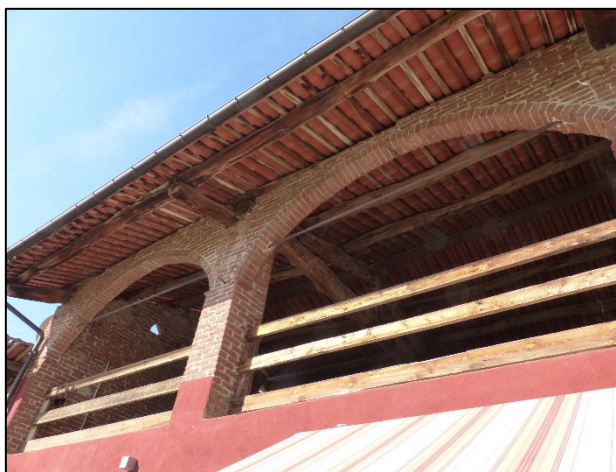
Fotografia n. 26 - Deposito al piano primo (329 sub 2).
