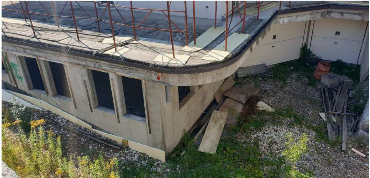
RAMPA DI ACCESSO ALL'INTERRATO
