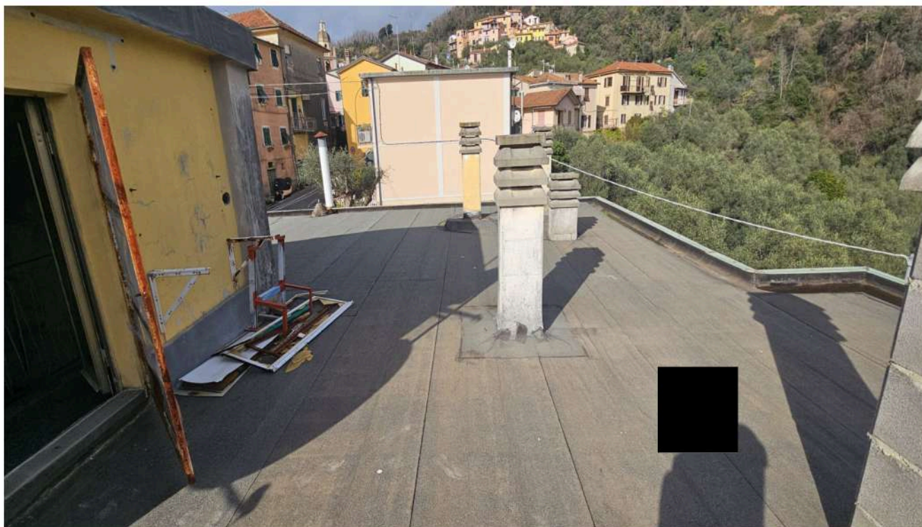
foto 6. Vista particolare solaio di copertura calpestabile
