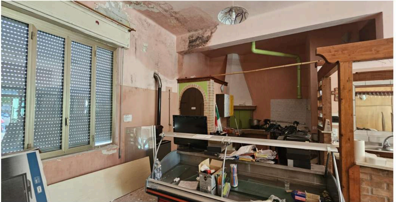
foto 3. Vista particolare locale commerciale
