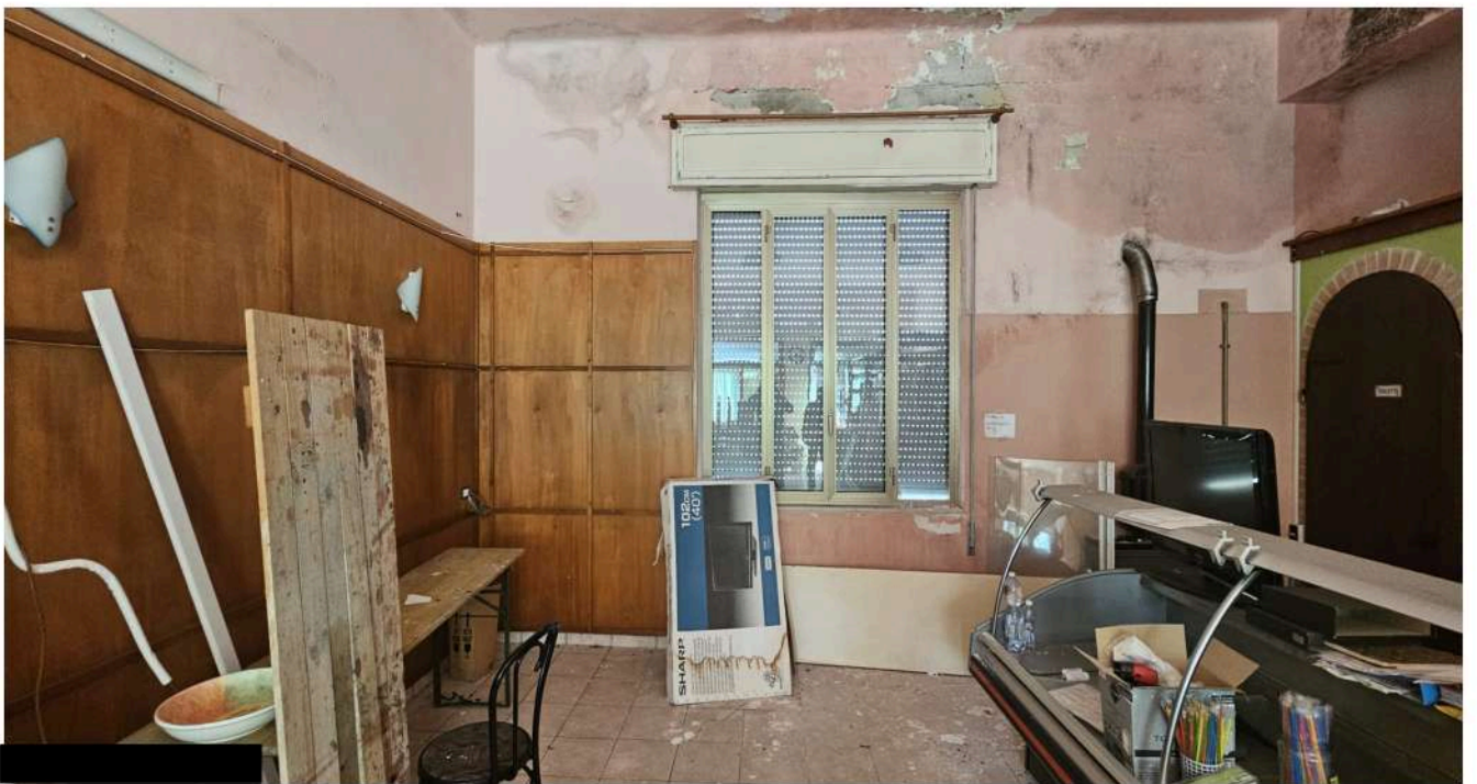
foto 4. Vista particolare locale commerciale
