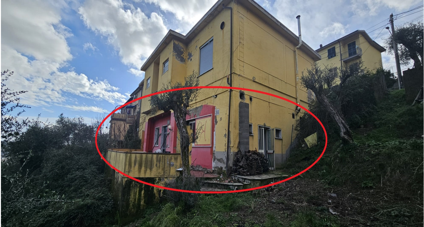
foto 2. Panoramica lato SUD-EST, ristorante al piano Seminterrato
