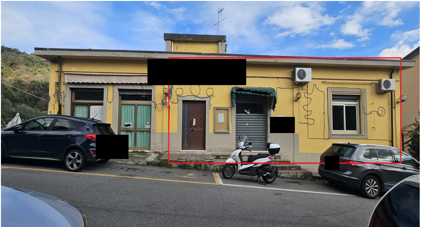
foto 2. Panoramica lato Ovest, Fondo commerciale al piano Terra.
