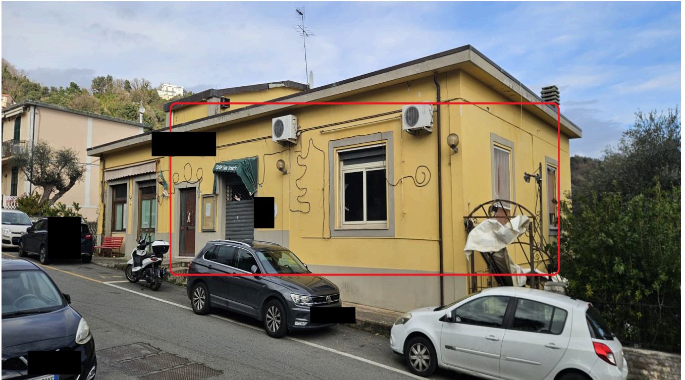
foto 1. Panoramica lato Sud-Ovest, Fondo commerciale al piano Terra.
