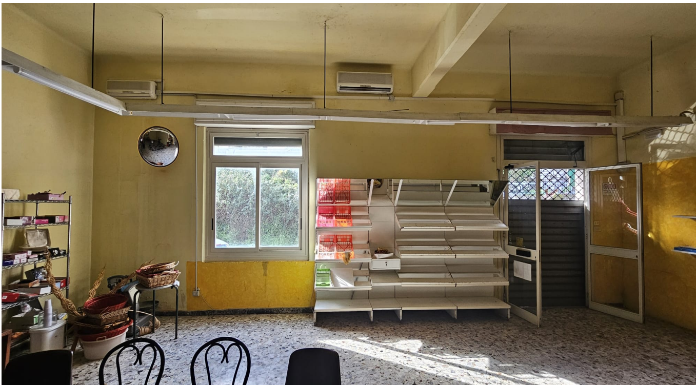
foto 4. Vista particolare locale commerciale
