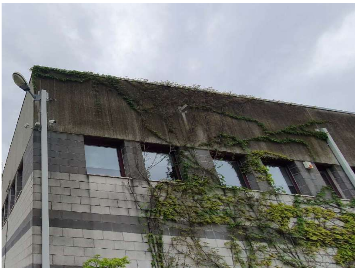
Foto 20 impianto di videosorveglianza perimetrale e di allarme
