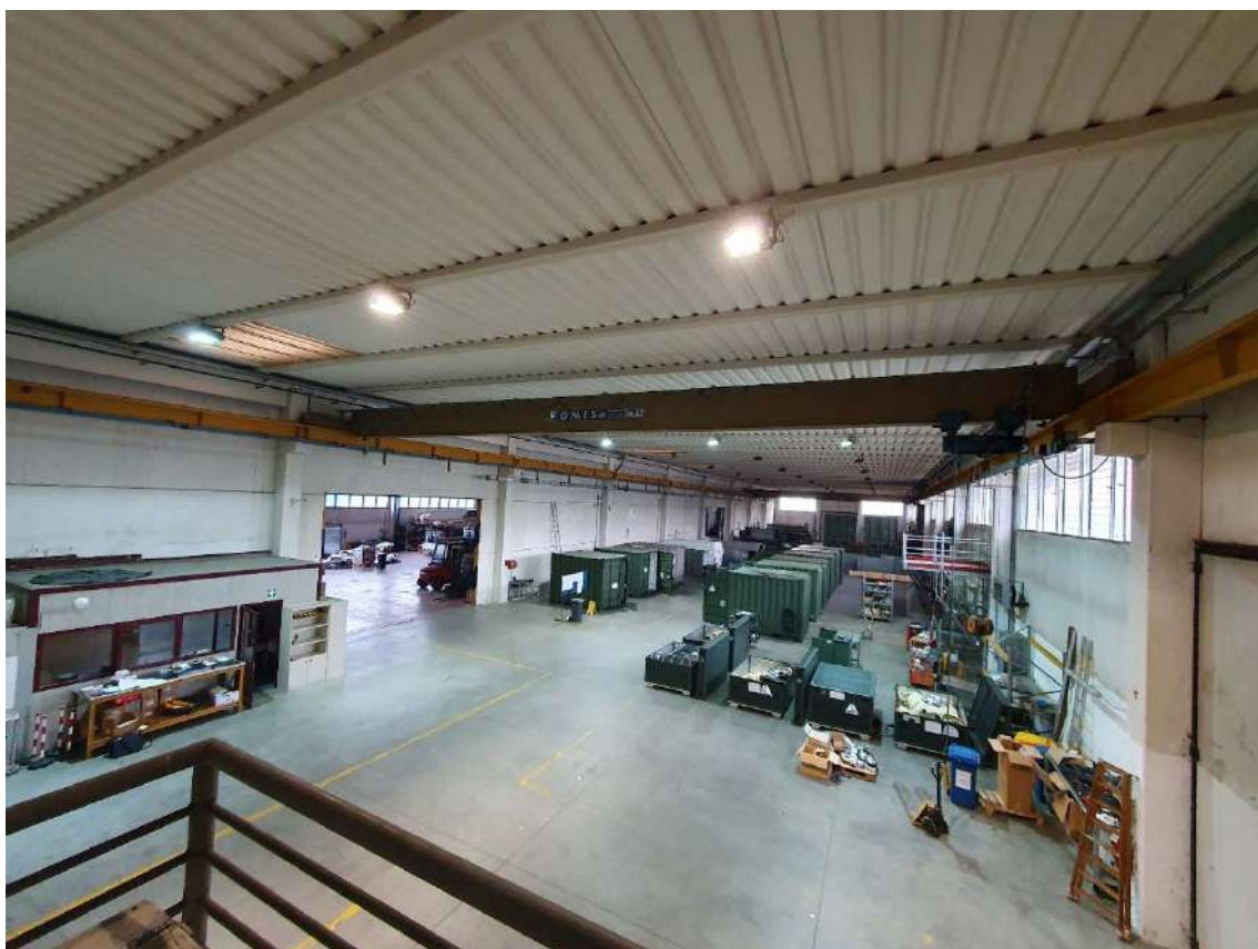
Foto 10 capannone campata sud-ovest
