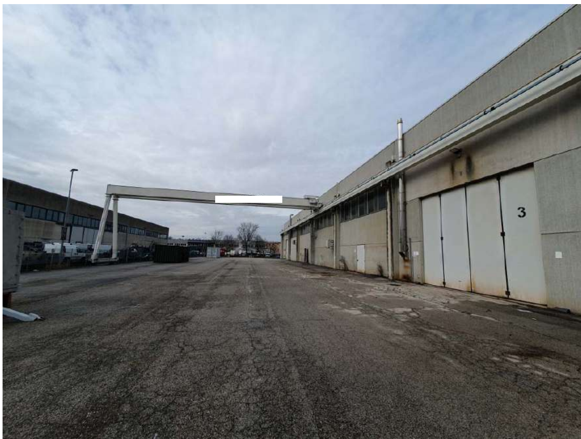
Foto 18 area esterna lato sud-est e carro ponte esterno
