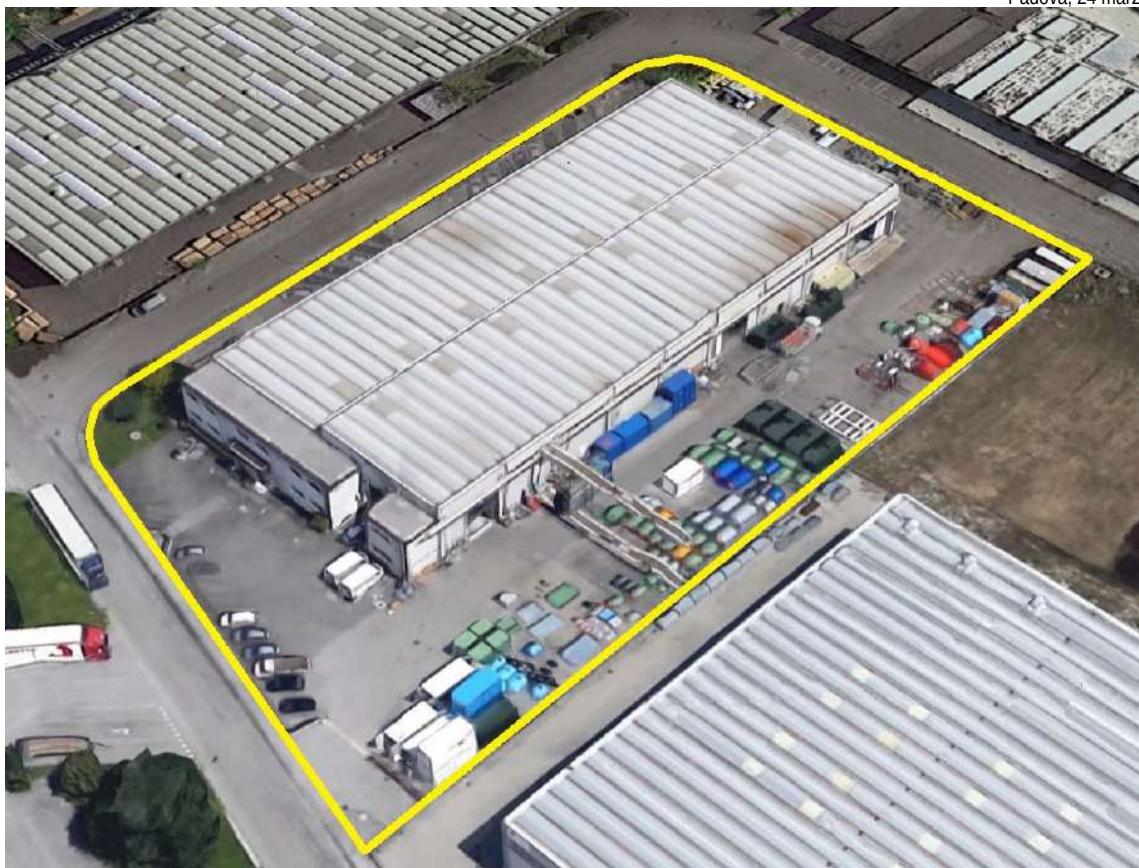
Foto 1 vista aerea dell'immobile con indicazione dell'area di pertinenza
