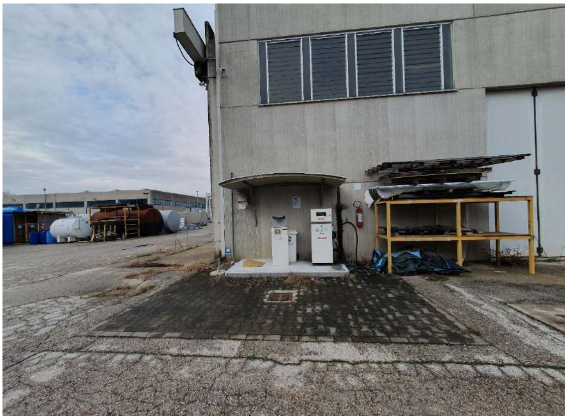
Foto 16 area esterna lato sud-est distributore carburante
