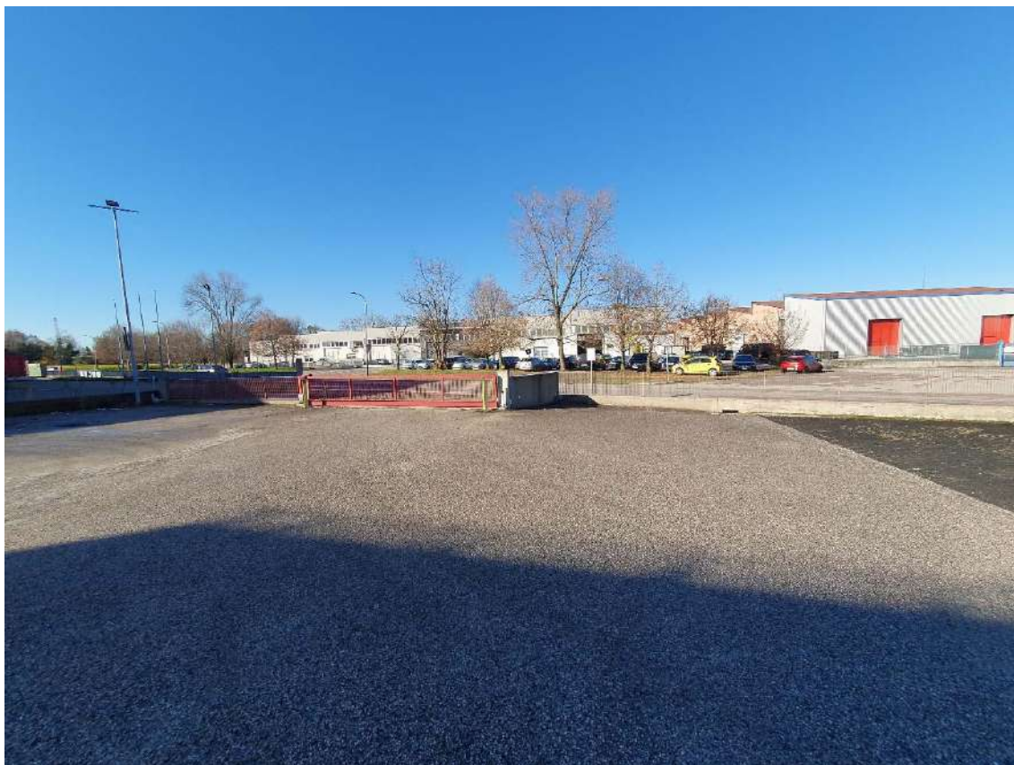
Foto 3 piazzale lato nord-ovest e ingresso carraio
