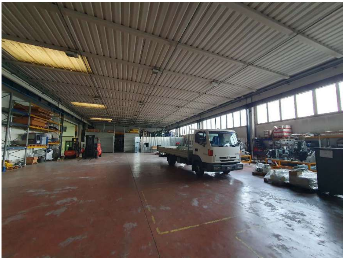
Foto 13 capannone campata nord-est
