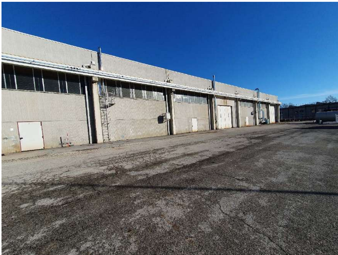
Foto 5 prospetto sud-ovest del laboratorio
