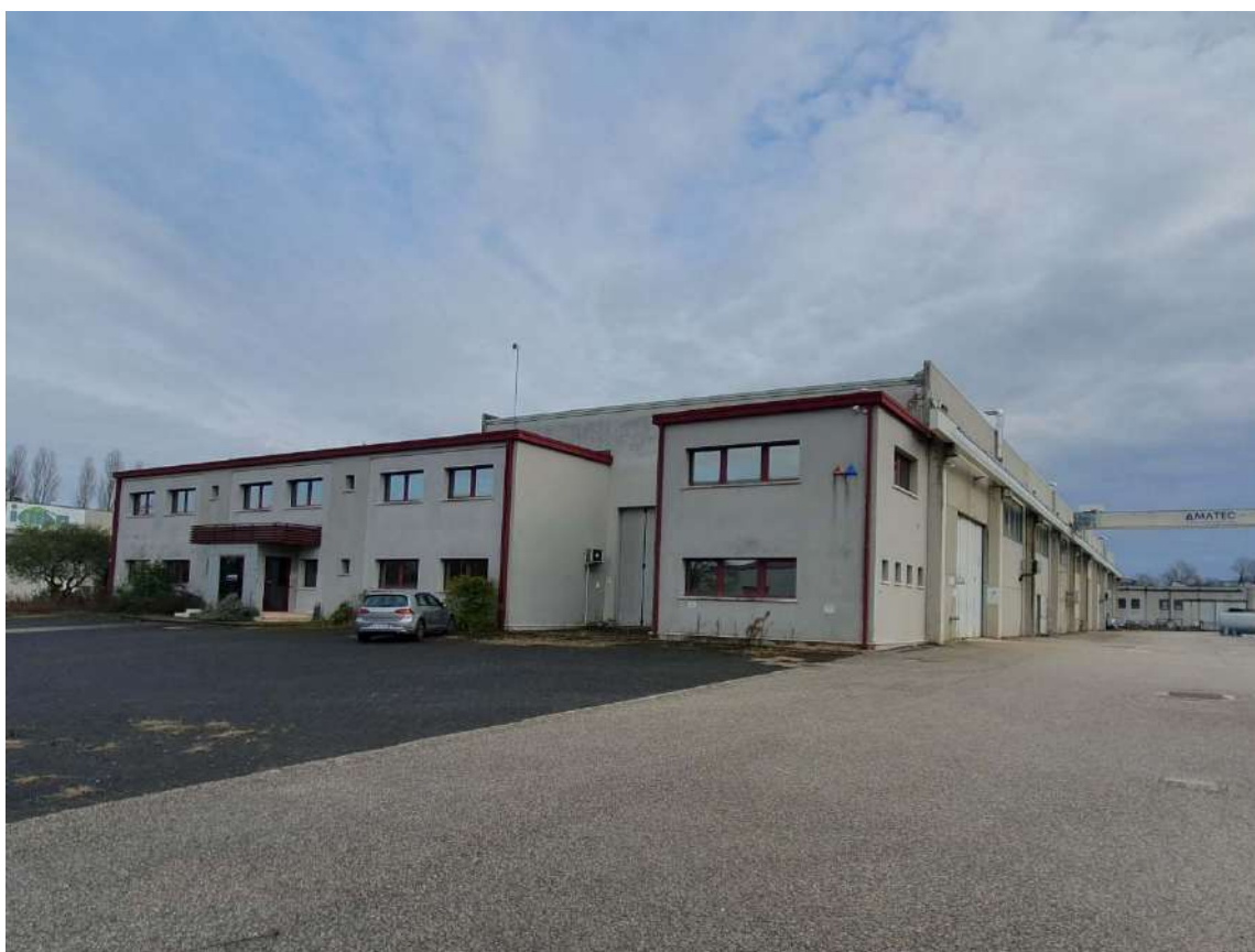
Foto 2 ingresso uffici lato nord-ovest
