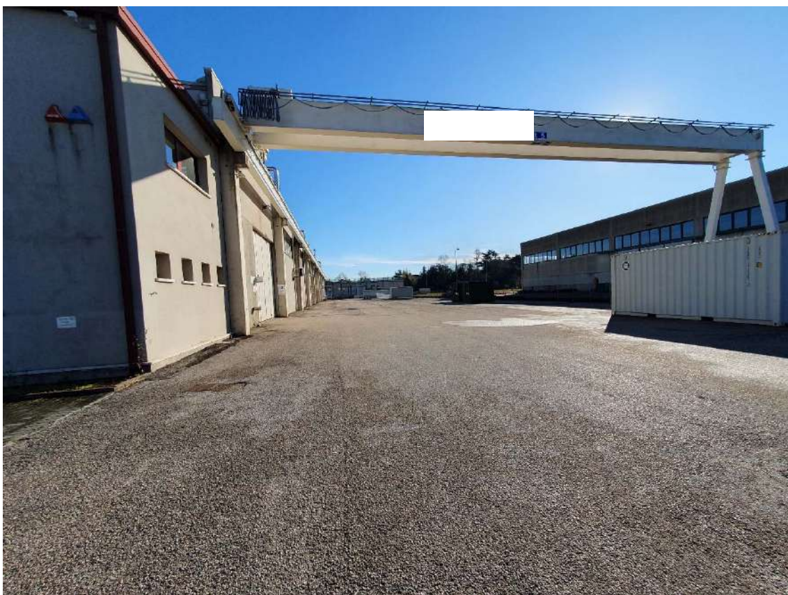
Foto 4 piazzale lato nord-ovest e carroponte a cavalletto
