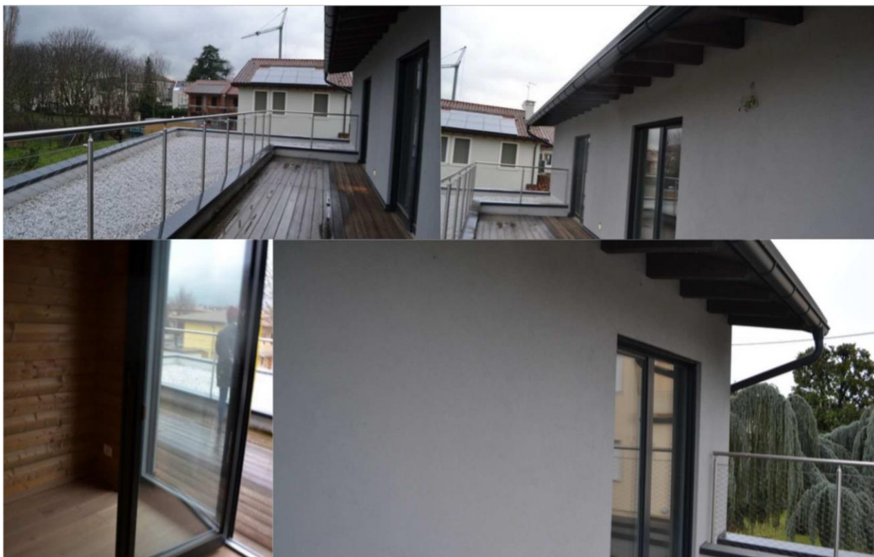
Figure 19- PIANO PRIMO -Terrazza in listoni di legno e dettaglio parete e serramento seconda camera matrimoniale;
