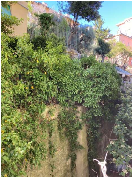
21 vista da camera
