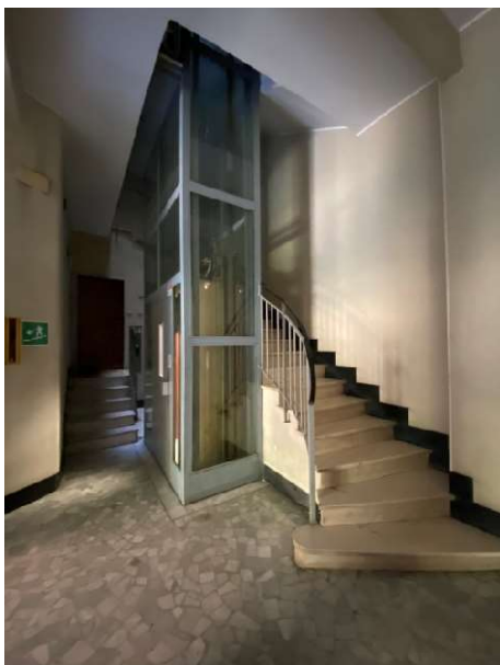
9 ascensore e vano scala
