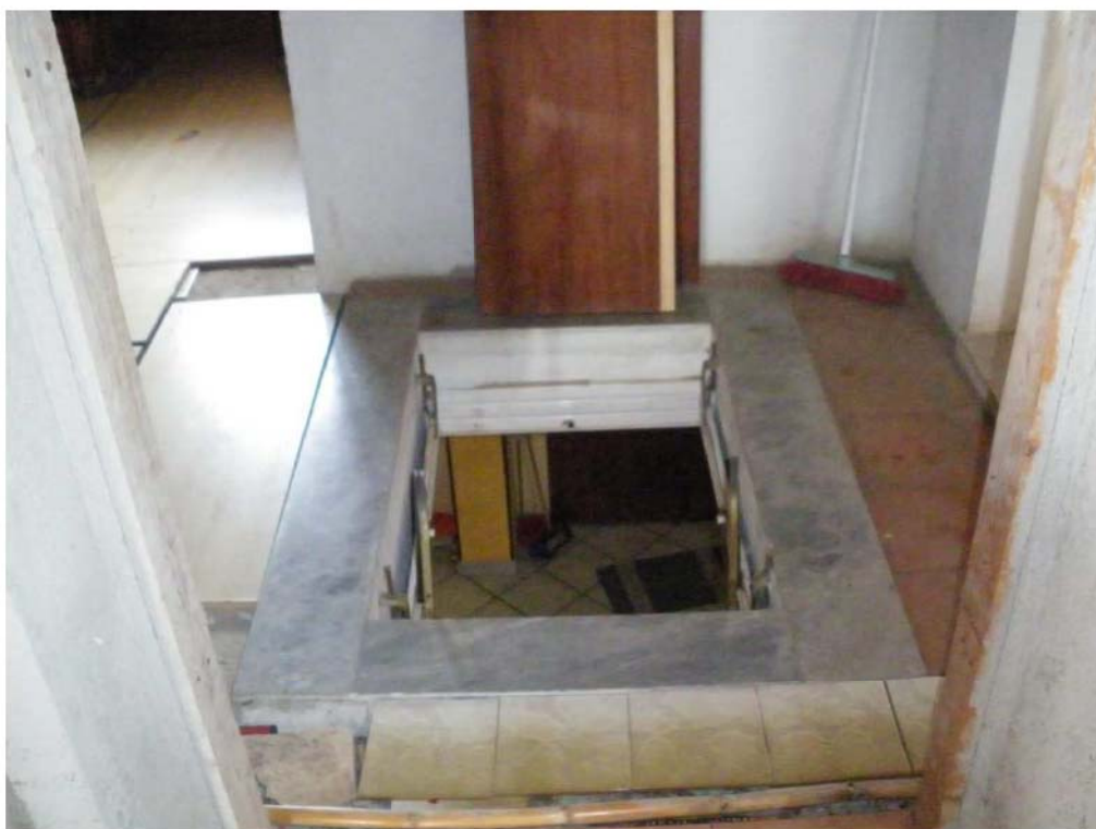
FOTO N° 18 – BOTOLA D'ACCESSO AL PIANO SECONDO
