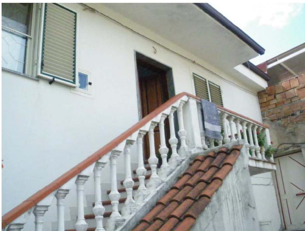
FOTO N° 10 – SCALA D'ACCESSO AL PRIMO PIANO
