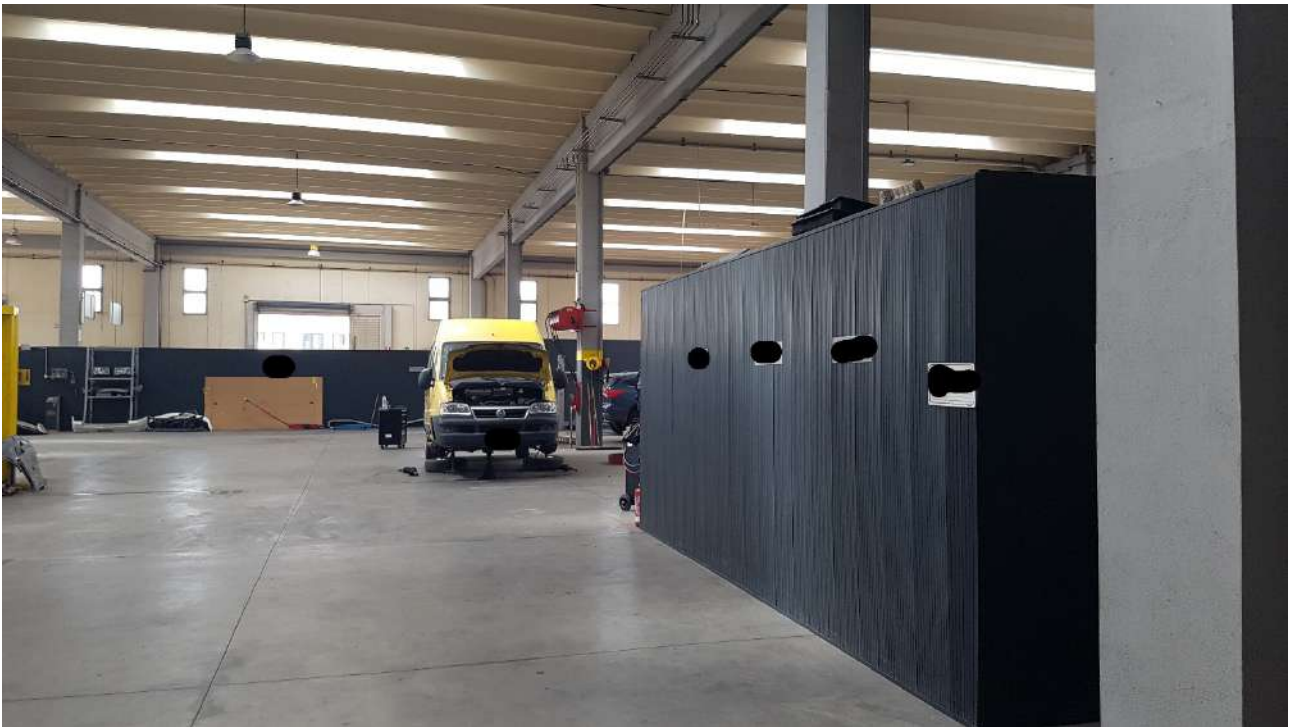
Foto 7- Interno piano terra
