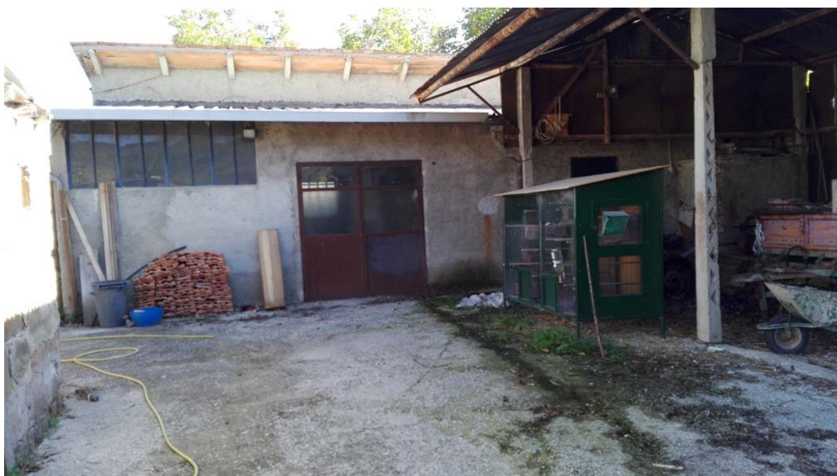
FOTO 28 – fabbricato su particella 1000
