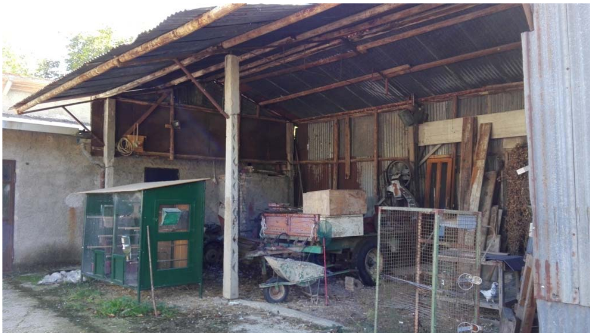
FOTO 29 – fabbricato su particella 1000
