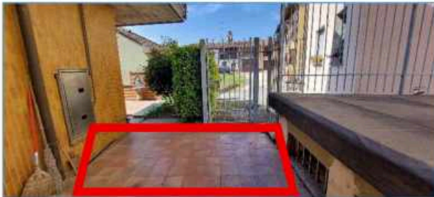
Terrazzo sopra loc. di deposito
