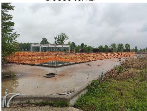
Piscina – Edificio impianti
