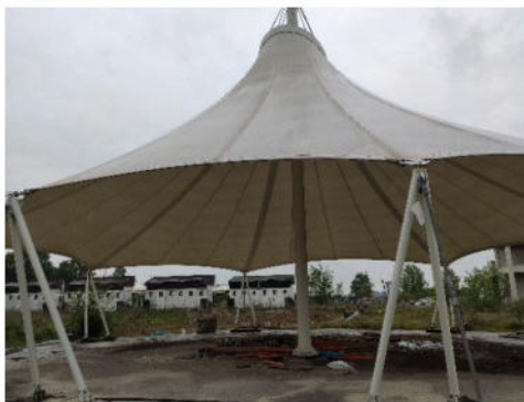
Tensostruttura area bar
