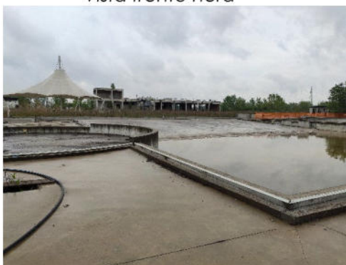
Vista da fronte sud
