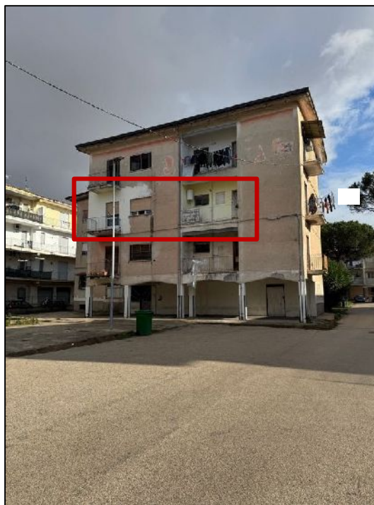
Foto 2 – Fabbricato “Isolato 7 scala A”
