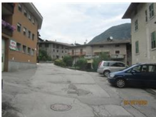
VISTA DA STRADA EDIFICIO LATO SUD
