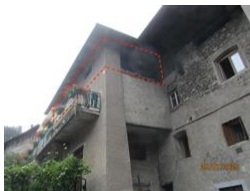
VISTA EDIFICIO LATO EST
