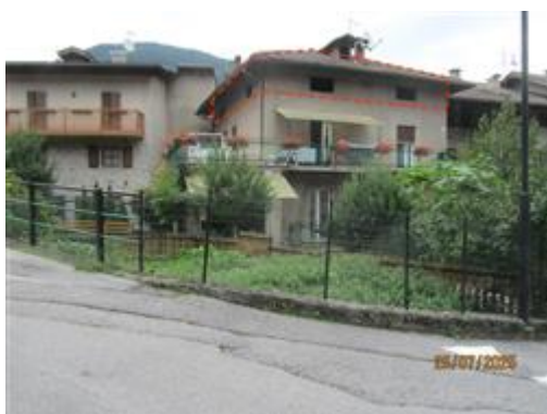
VISTA EDIFICIO LATO SUD
