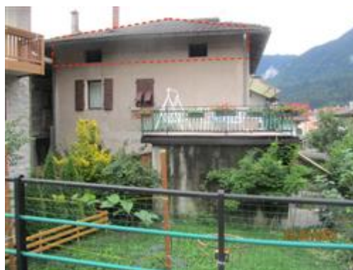
VISTA EDIFICIO LATO OVEST
