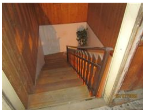
VISTA SU VANO SCALA COMUNE
