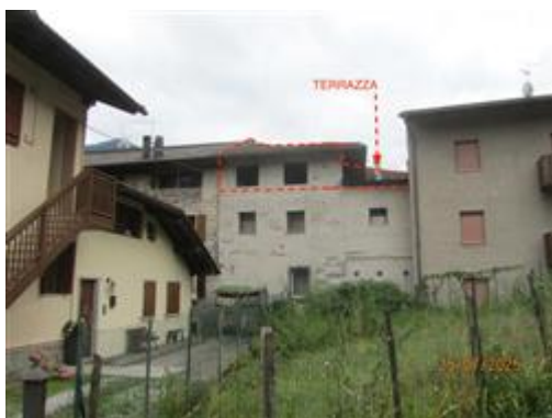
VISTA EDIFICIO LATO NORD
