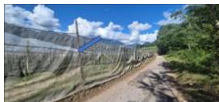
strada comunale lato sud - in evidenza recinzione esterna
