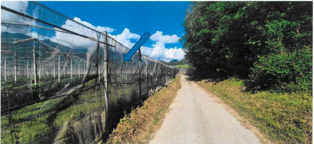
STRADA COMUNALE LATO SUD (in evidenza recinzione esterna)
