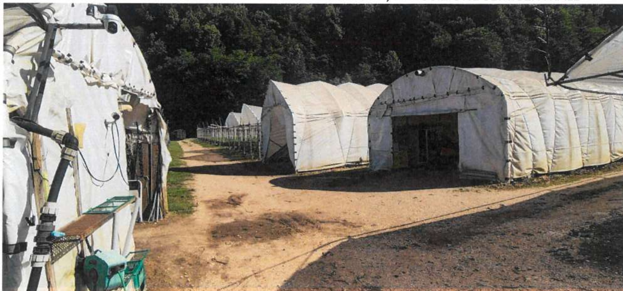
TENSOSTRUTTURE AGRICOLE POSTE SUL LATO NORD, IN POSIZIONE SEMICENTRALE
