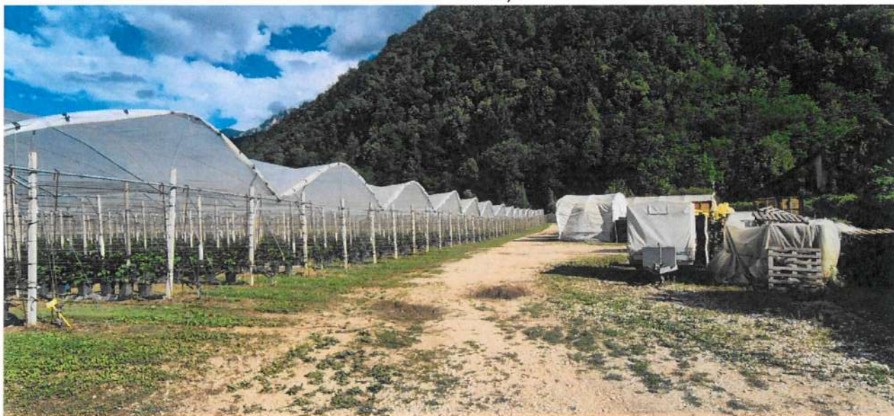
TENSOSTRUTTURE AGRICOLE POSTE SUL LATO EST, IN PROSSIMITA' DEL PRIMO ACCESSO
