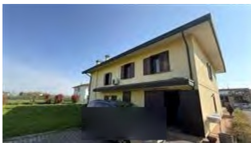
Vista esterna edificio
