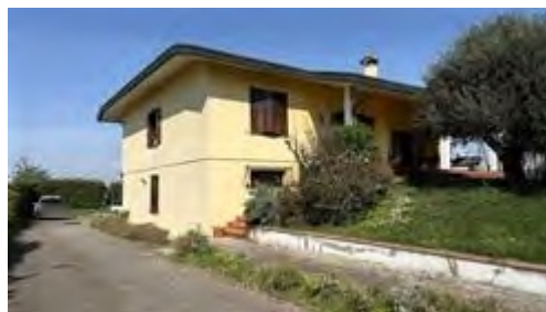
Vista esterna edificio
