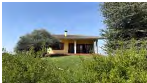
Vista esterna edificio
