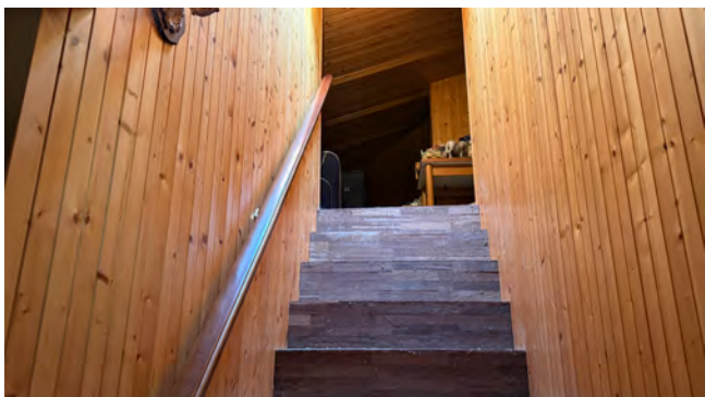
Foto 11-1 – Vista vano scale soffitta
