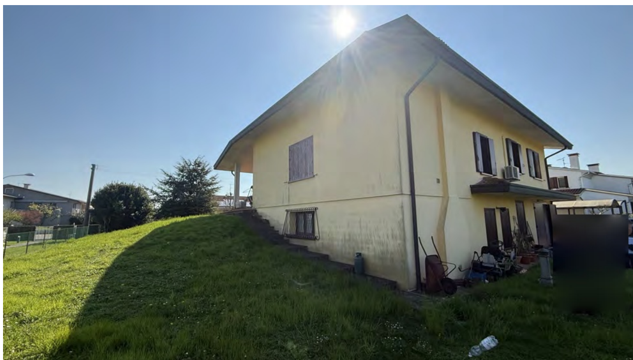
Foto B – Vista esterna dal giardino
