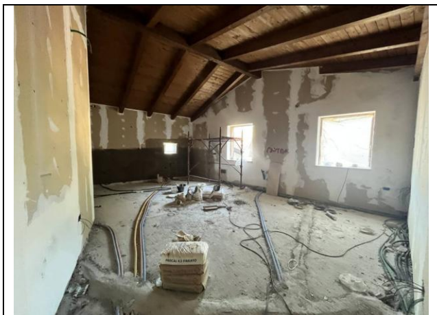
Foto 39-40 – Piano primo: Visibile l'ulteriore grande ambiente con copertura in legno a doppia falda dotato di: tre aperture verso l'esterno, ed installazione di pannelli isolanti sulle pareti con realizzazione di impiantistica a pavimento .
