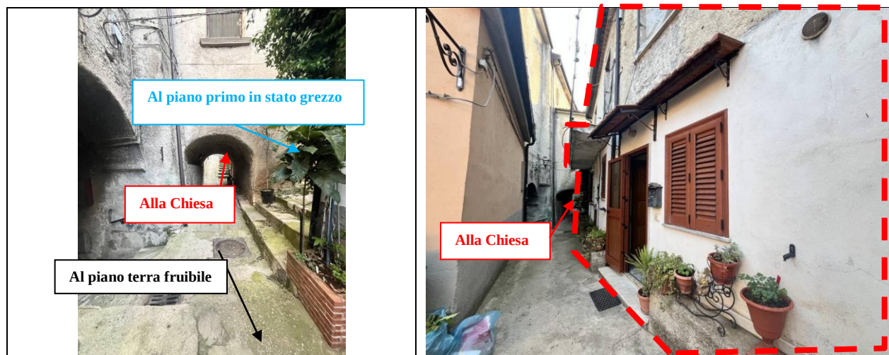
Foto 7-8: Visibile il sottopasso comune di Via Duomo , ripreso da due diverse angolazioni, e, nella foto a destra (tratteggiato in rosso), il piano terra del fabbricato eseguito. Pur essendo Tragitto esclusivamente pedonale, la Via Duomo è provvista di rete fognaria e pubblica illuminazione .
