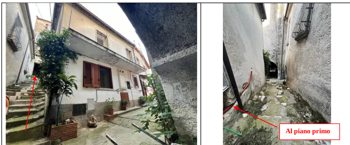
Foto 29-30 – Piano primo: L'accesso al secondo piano avviene da scala comune, traversa di Via Duomo, ed attigua al fabbricato.
