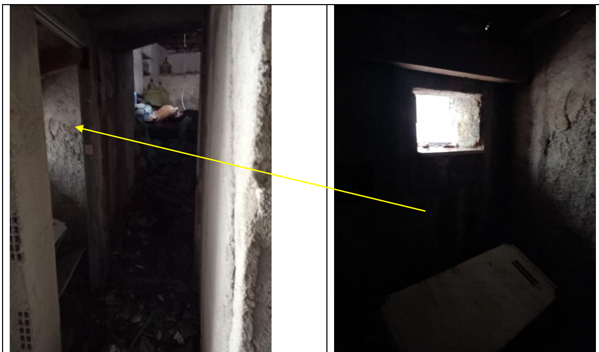
Foto 33-34 – Piano primo: Il primo disimpegno adduce ad una retrostante cantina di servizio , senza illuminazione diretta ed in stato rustico, e ad un piccolo ambiente di servizio dotato di apertura sul prospetto laterale.
