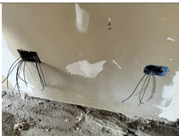
Foto 41-42-43-44 – Piano primo: Particolari dell' impiantistica elettrica ed idrica esistente , pur non ancora ultimata e da mettere sotto-traccia.
