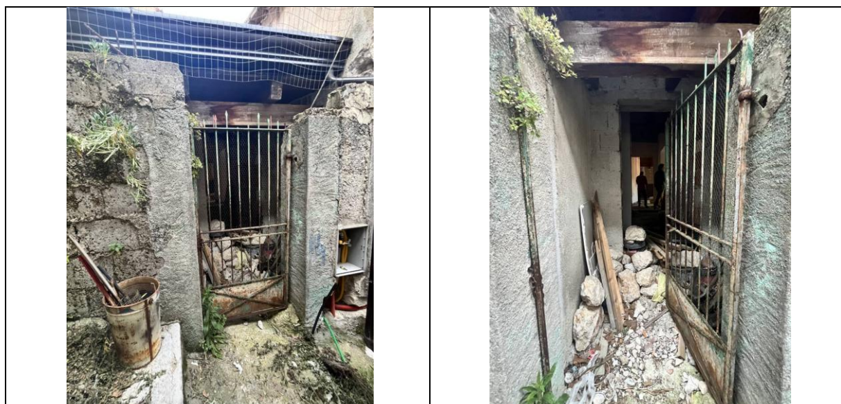
Foto 31-32 – Piano primo: L'ingresso al primo piano avviene, attualmente da porta in ferro: visibile lo stato di cantierazione interrotta in cui si trova il piano primo.
