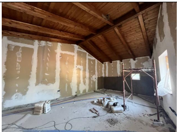
Foto 39-40 – Piano primo: Visibile l'ulteriore grande ambiente con copertura in legno a doppia falda dotato di: tre aperture verso l'esterno, ed installazione di pannelli isolanti sulle pareti con realizzazione di impiantistica a pavimento .
