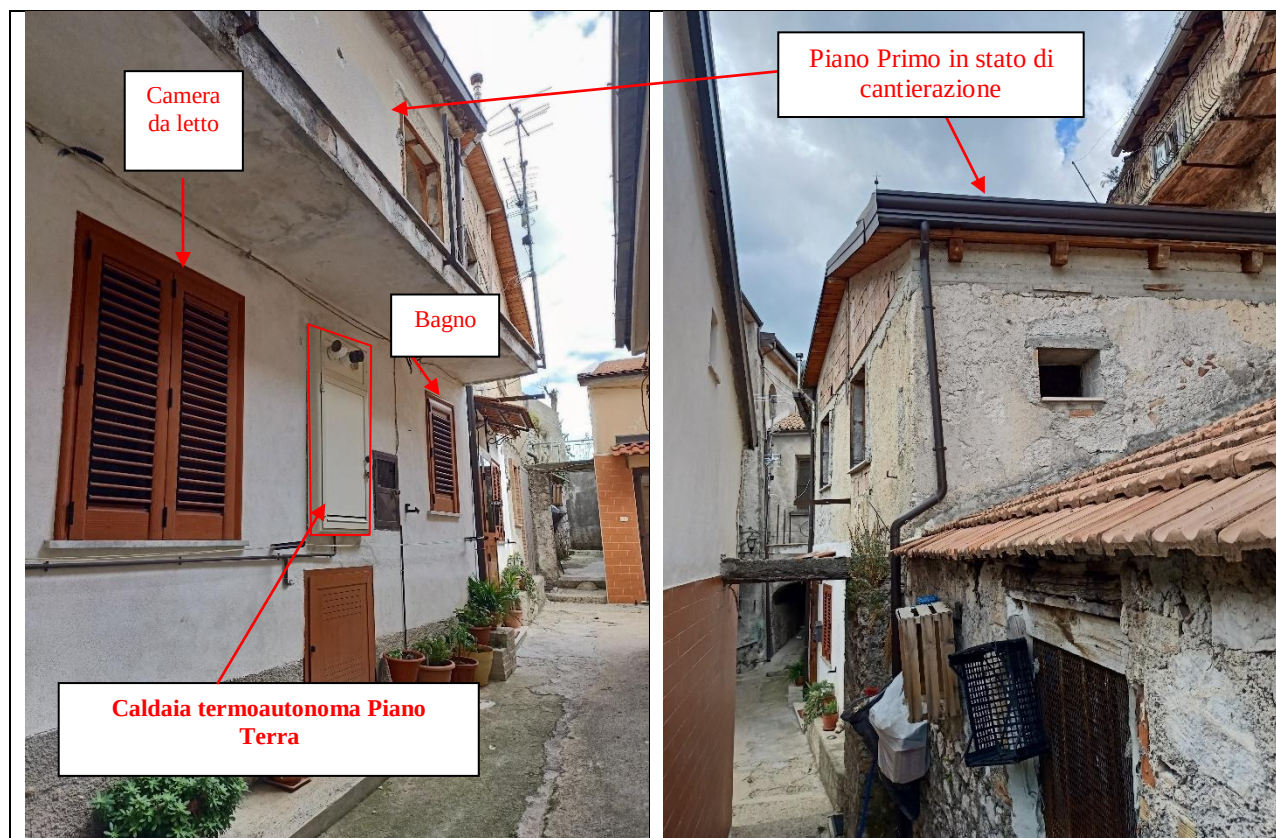
Foto 11-12: Prospetto principale e prospetto laterale con indicazione dei piani e degli ambienti di cui è costituito il cespite esecutato. Visibile inoltre vano caldaia termoautonoma a gas metano che alimenta cucina e riscaldamento a Piano Terra, con ambienti immediatamente fruibili allo stato.
