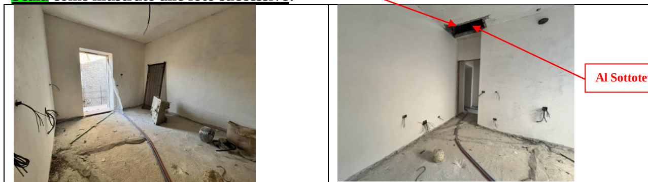
Foto 35-36-37-38 – Piano primo: Tramite il secondo disimpegno, visibile nella foto in alto a sinistra, è possibile raggiungere i due vani principali dotati di apertura balconata priva di ringhiera da apporsi, sul prospetto principale lato Via Duomo . In particolare, il Vano posto sul fondo del disimpegno, presenta poi una botola di accesso al sottotetto attualmente priva di Scala come illustrato alle foto successive:→
