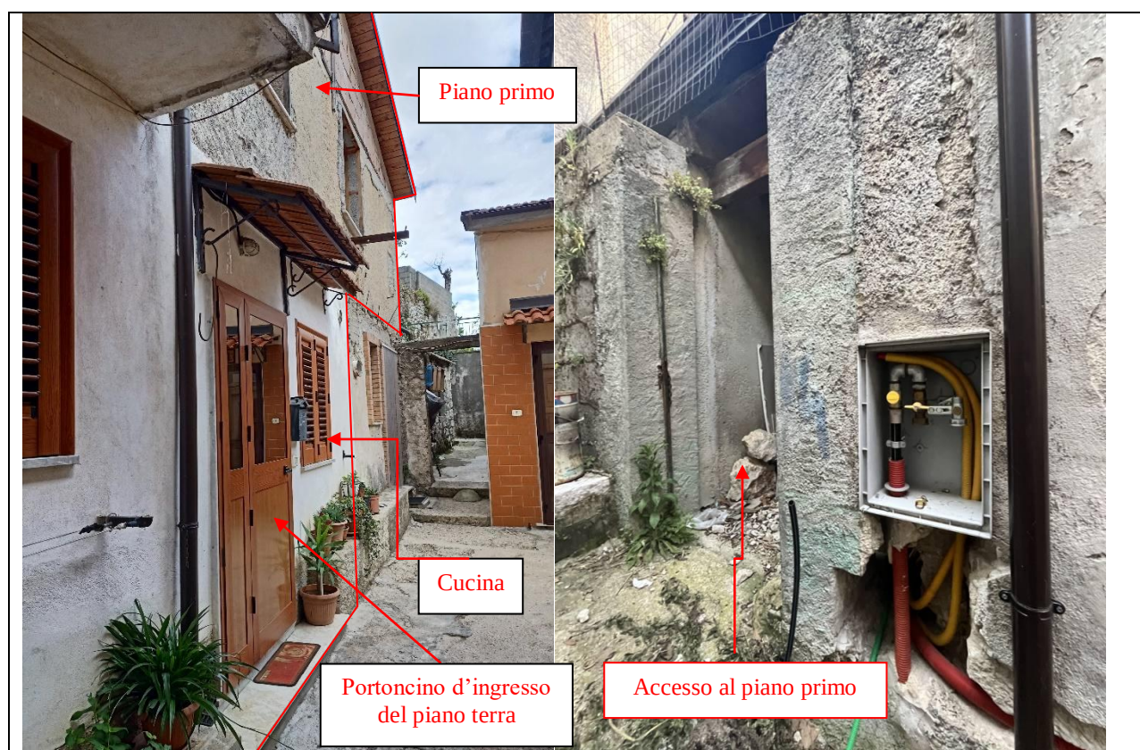
Foto 9-10: Il Lotto Unico si compone di due livelli tra loro indipendenti , ciascuno dotato di accesso proprio e separato. Infatti sono visibili, nella foto a sinistra, l'accesso di pianterreno (civico 5/1) e, nella foto a destra, attraverso scala comune scoperta, l'accesso al piano primo (civico snc) .
