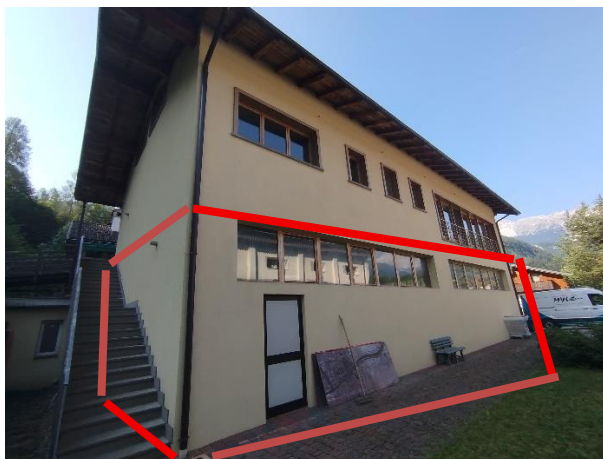
fronte nord-est piano terra
