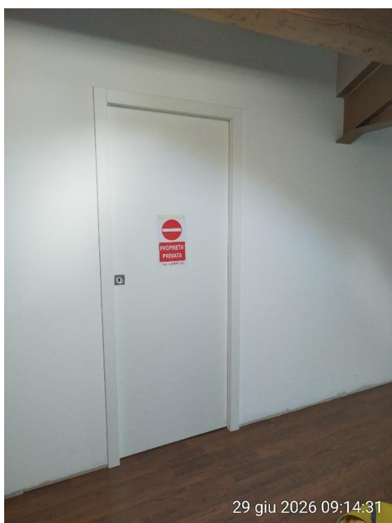
Da corridoio a seconda camera N.O.
