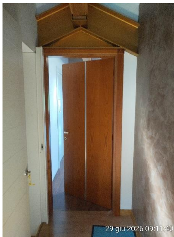
porta ingresso zona notte
