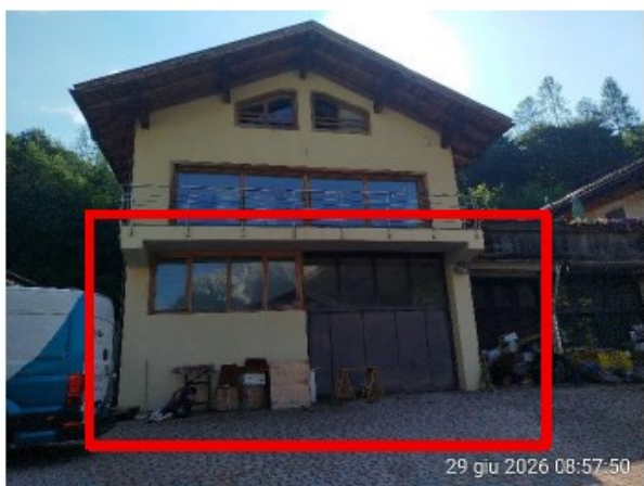
Fronte nord-ovest, piano terra
