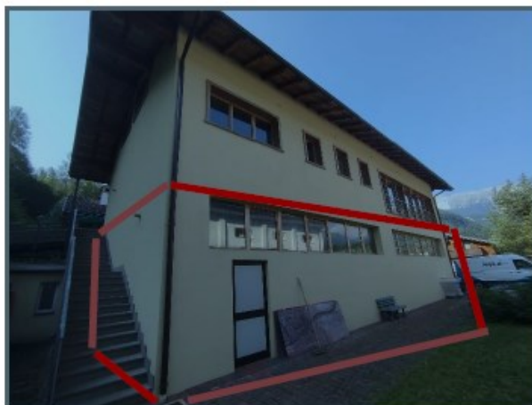
fronte nord-est piano terra
