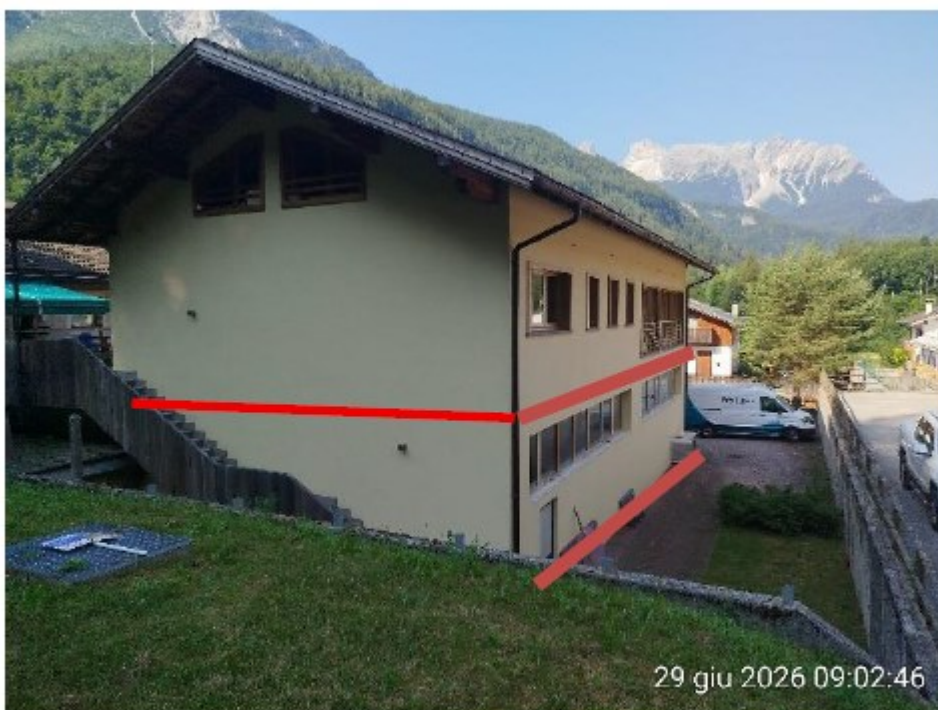
Fronte nord-ovest piano terra
