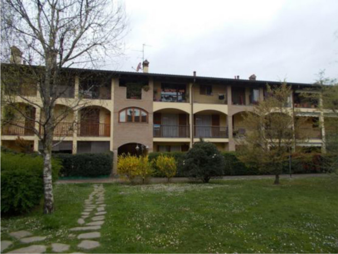
1. Panoramica corte interna condominio
