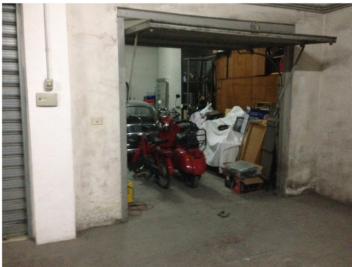
Foto 33 – primo interrato, autorimessa box, porta basculante
