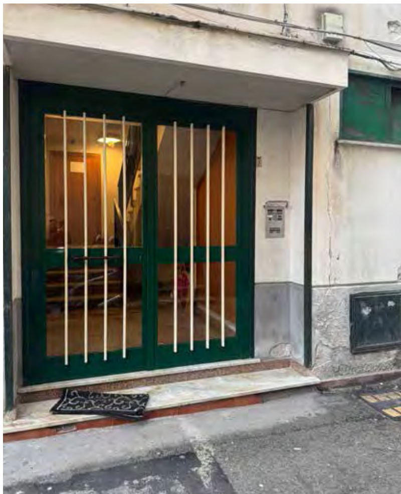
Foto n. 4: Il portone di ingresso alla palazzina.
