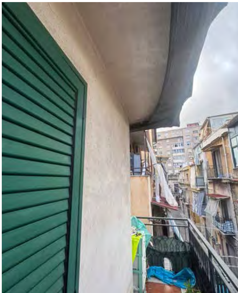
Foto n. 18: Il balcone. Vista verso la via Borgo Nuovo.
