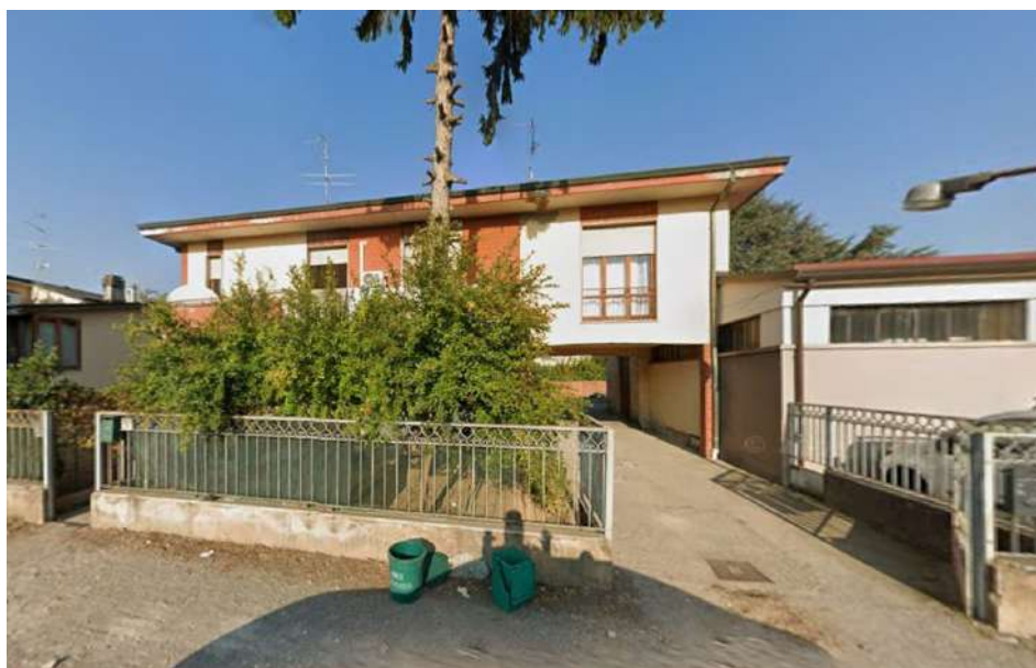
FOTO 4. vista sat. Ingresso all'immobile da via Trento e Trieste -
