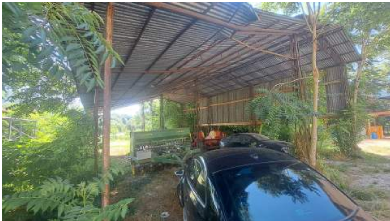
Vedute esterne del sub 5 – locali afferenti al manufatto ad uso tettoia
