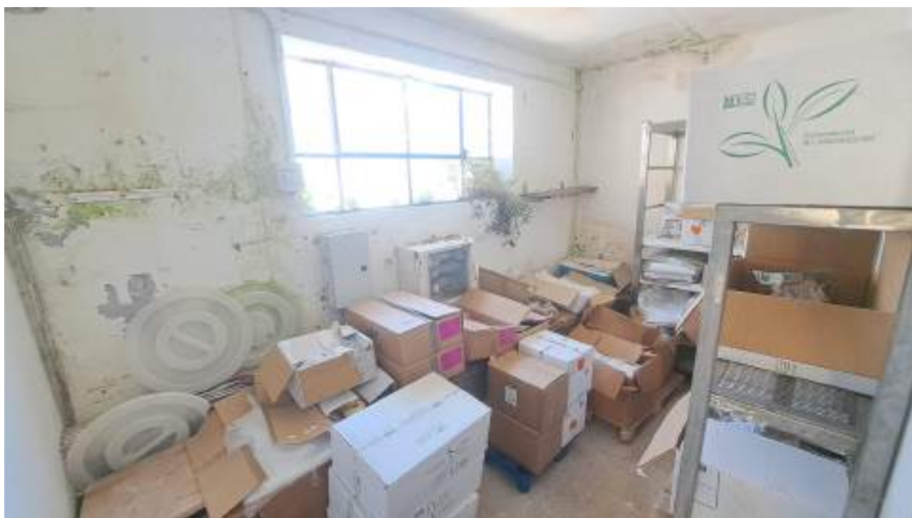
Vedute interne del sub 5 – locali afferenti al fabbricato ad uso magazzino
