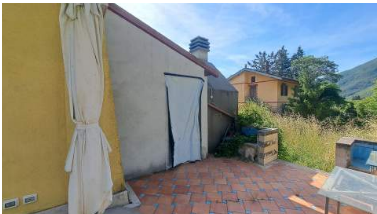
Vedute esterne del sub 5 piano terra – locale adibito ad agriturismo
