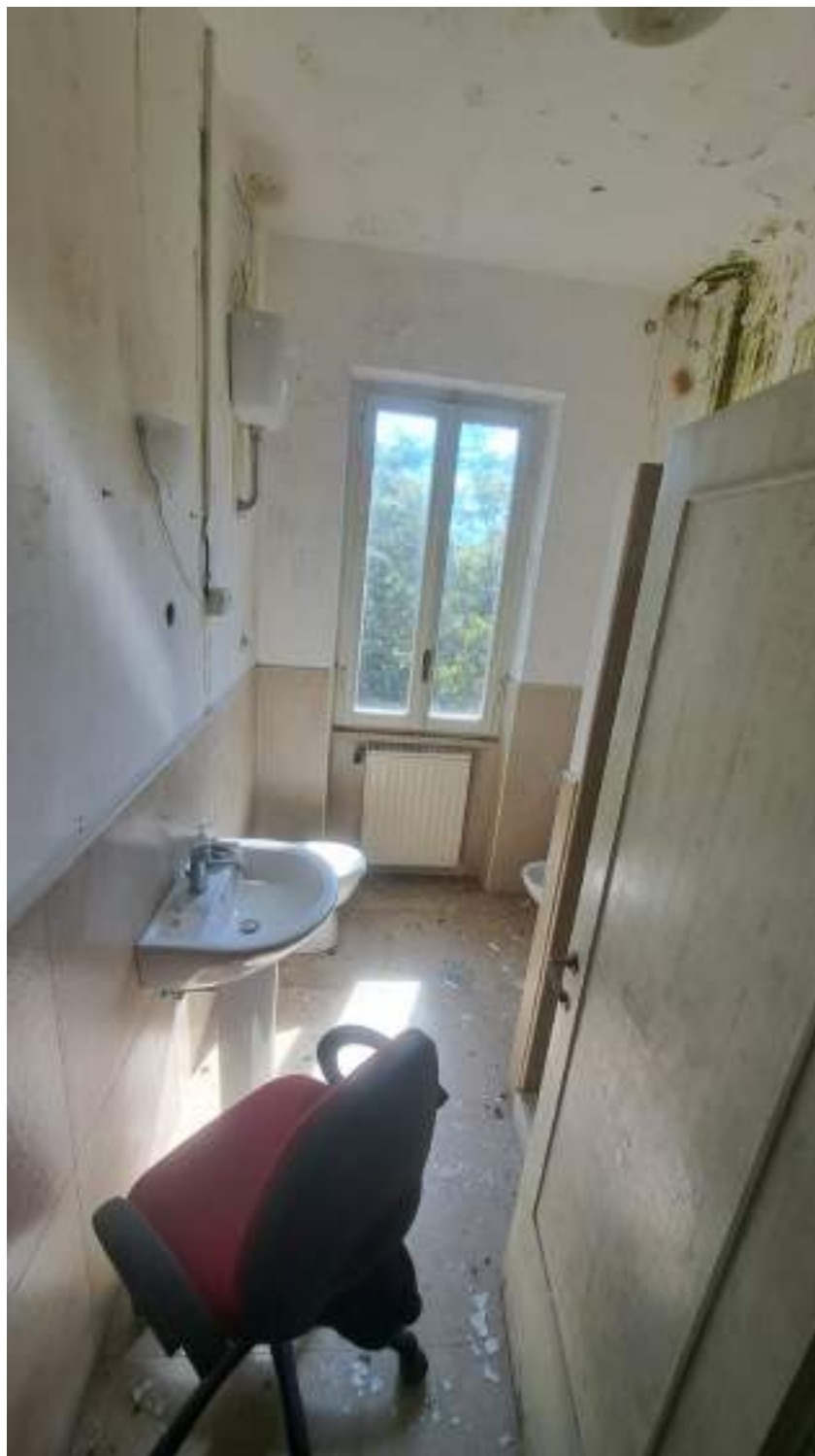
Vedute esterne della palazzina ad uso prevalentemente residenziale - sub 4 alloggio al piano primo
