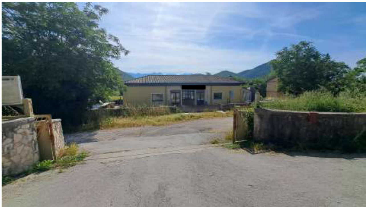
Veduta esterna dell'accesso dalla strada provinciale
