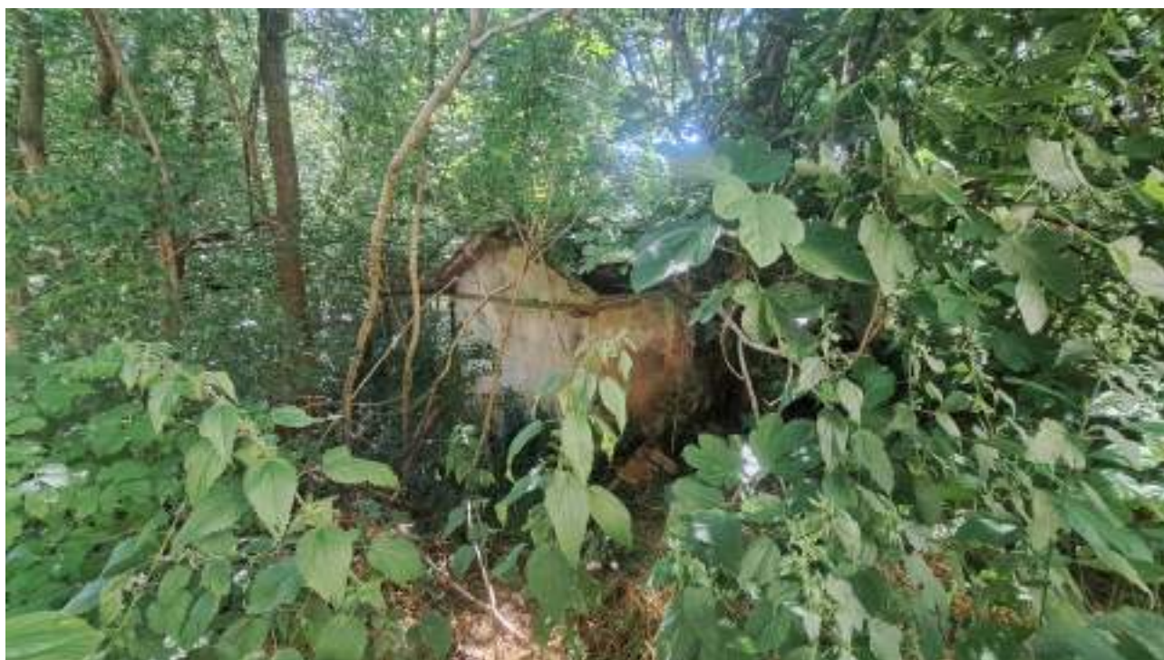
Vedute esterne del sub 5 – locali afferenti al manufatto ad uso pollaio – forno
