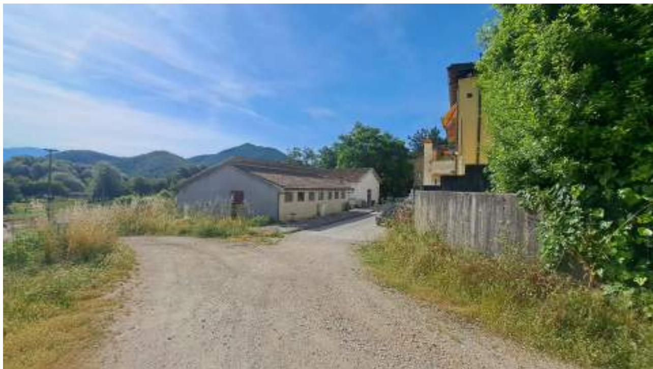
Vedute esterne del sub 5 – locali afferenti al fabbricato ad uso porcilaia
