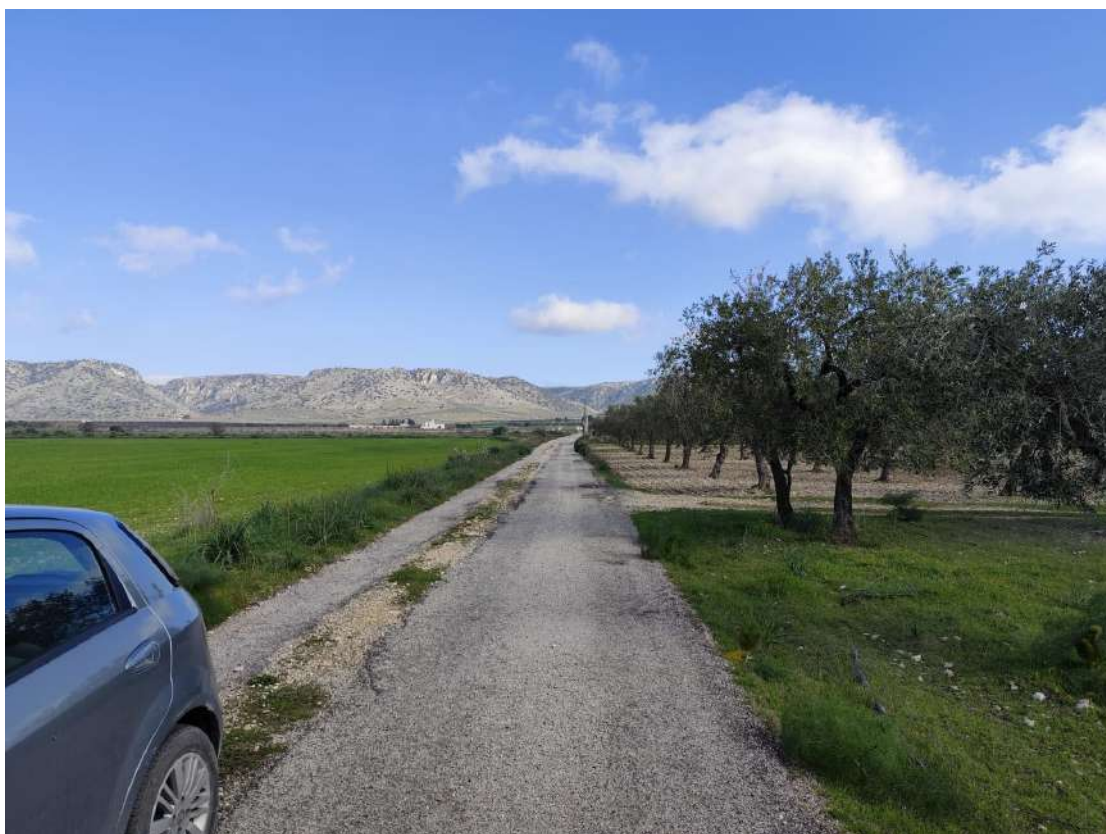
FOTO N. 7 – Vista della strada asfaltata che conduce alla S.P. 58.
