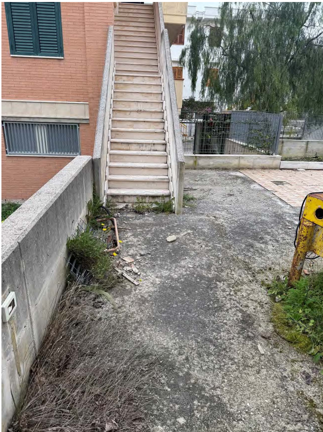
Foto 03 – Vista cortile e scala esterna di accesso
