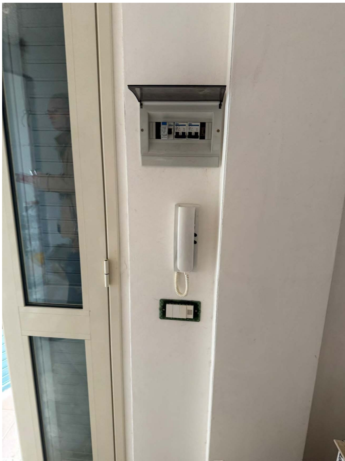
Foto 18 – Particolare zona ingresso
