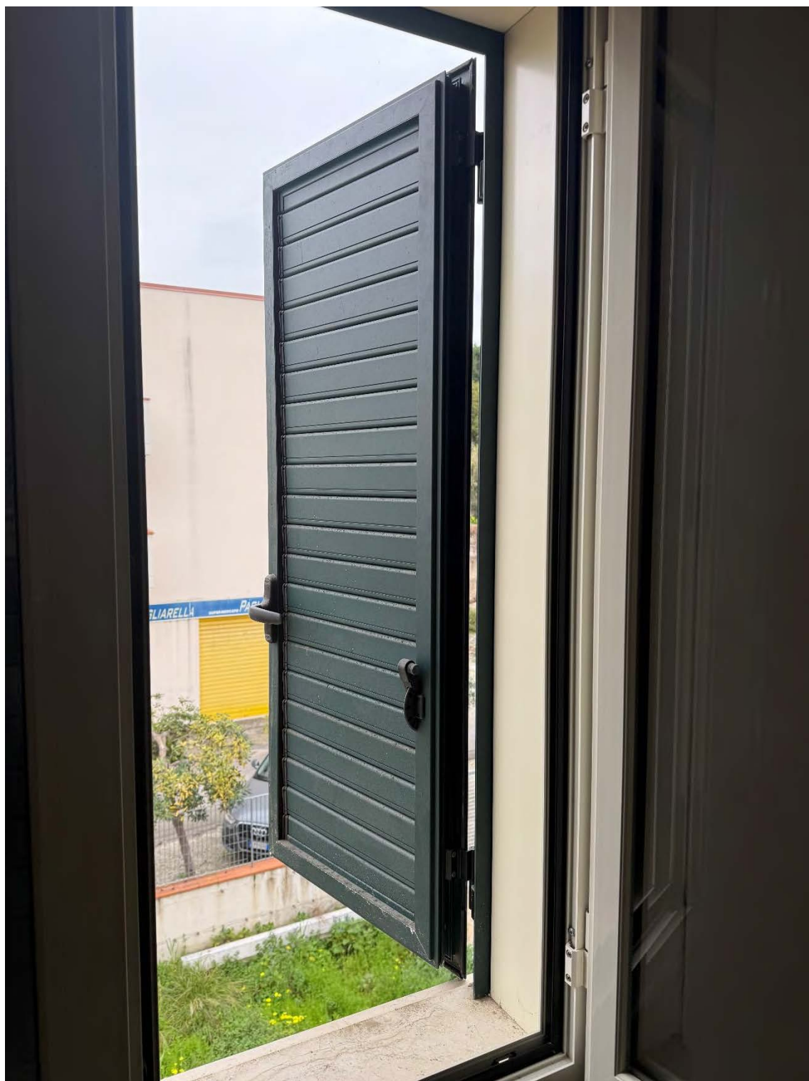
Foto 21 – Particolare infisso esterno
