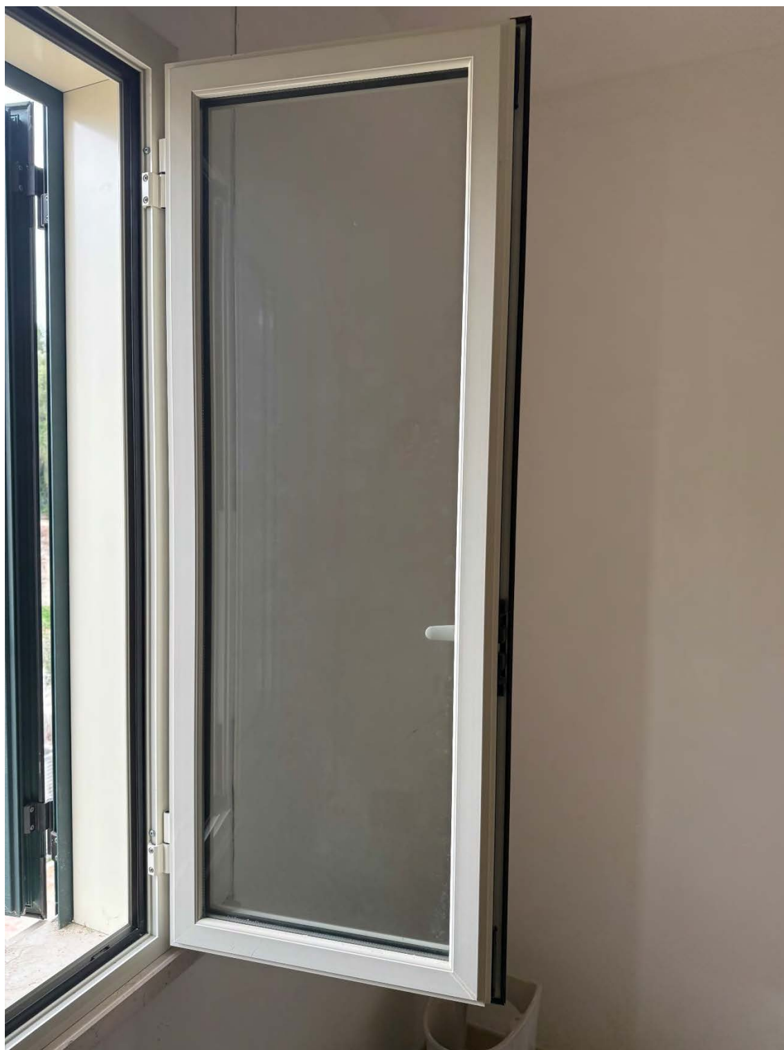
Foto 20 – Particolare infisso esterno
