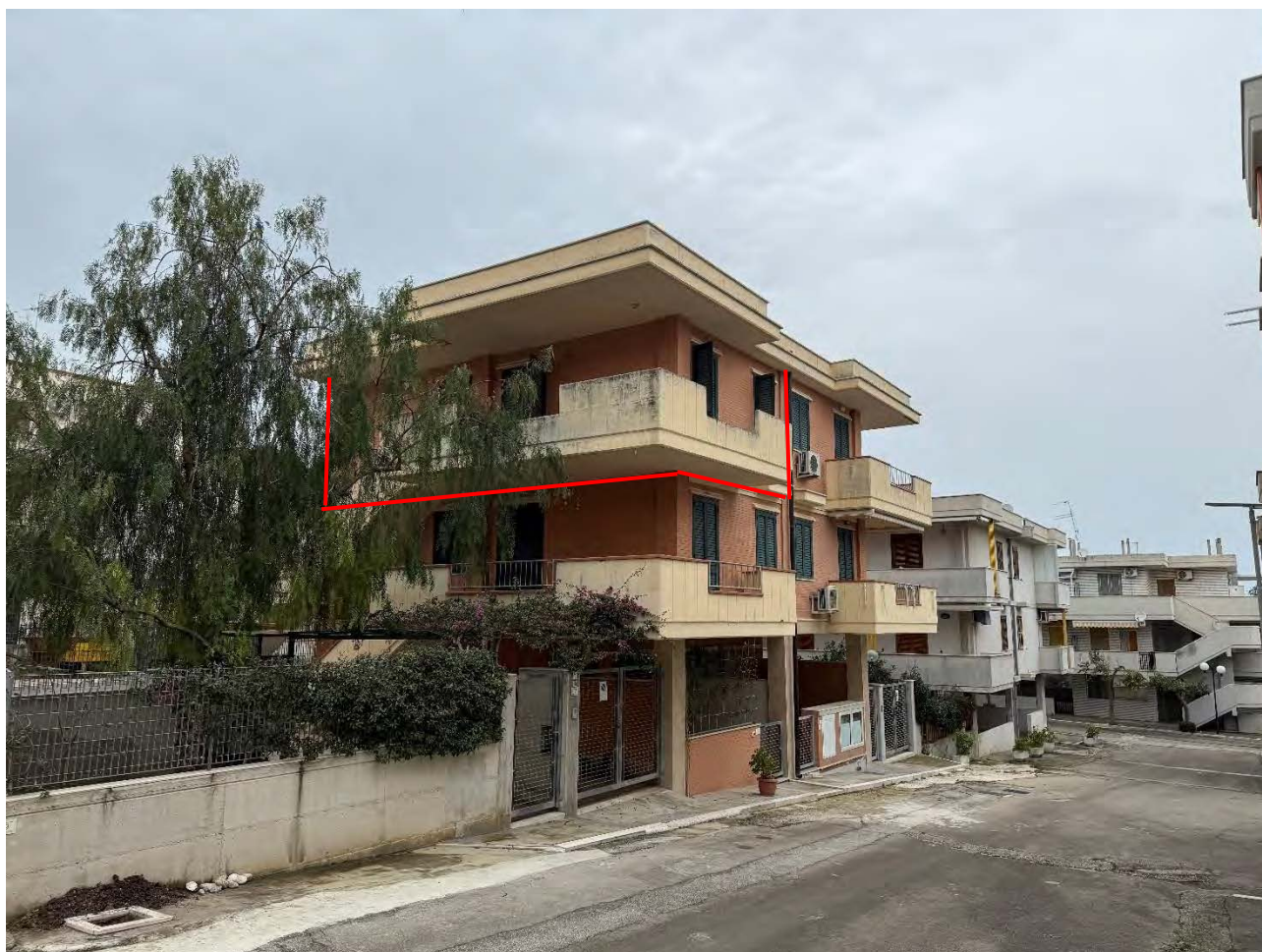
Foto 08 – Vista panoramica da strada a denominarsi
