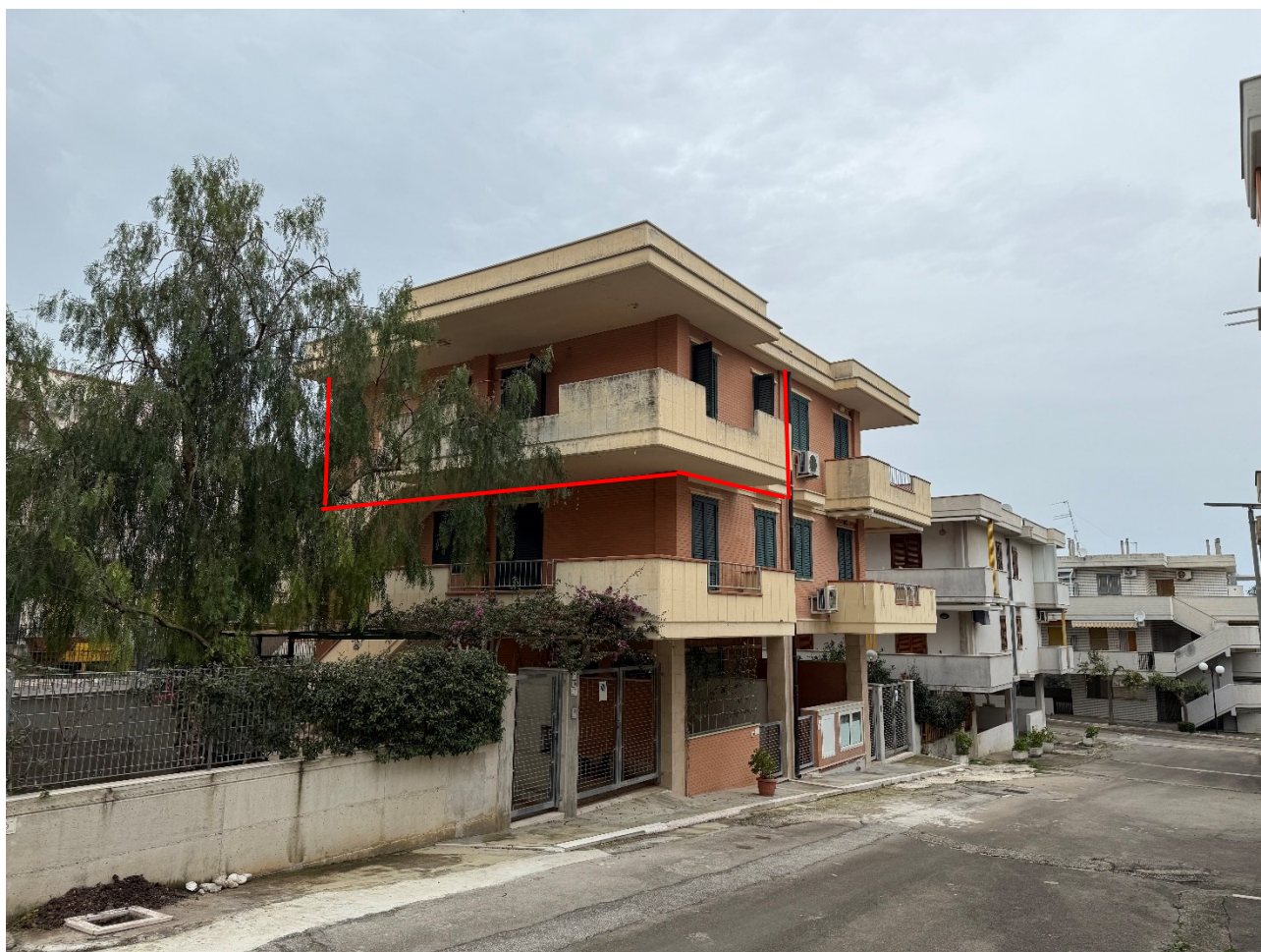
Foto 08 – Vista panoramica da strada a denominarsi
