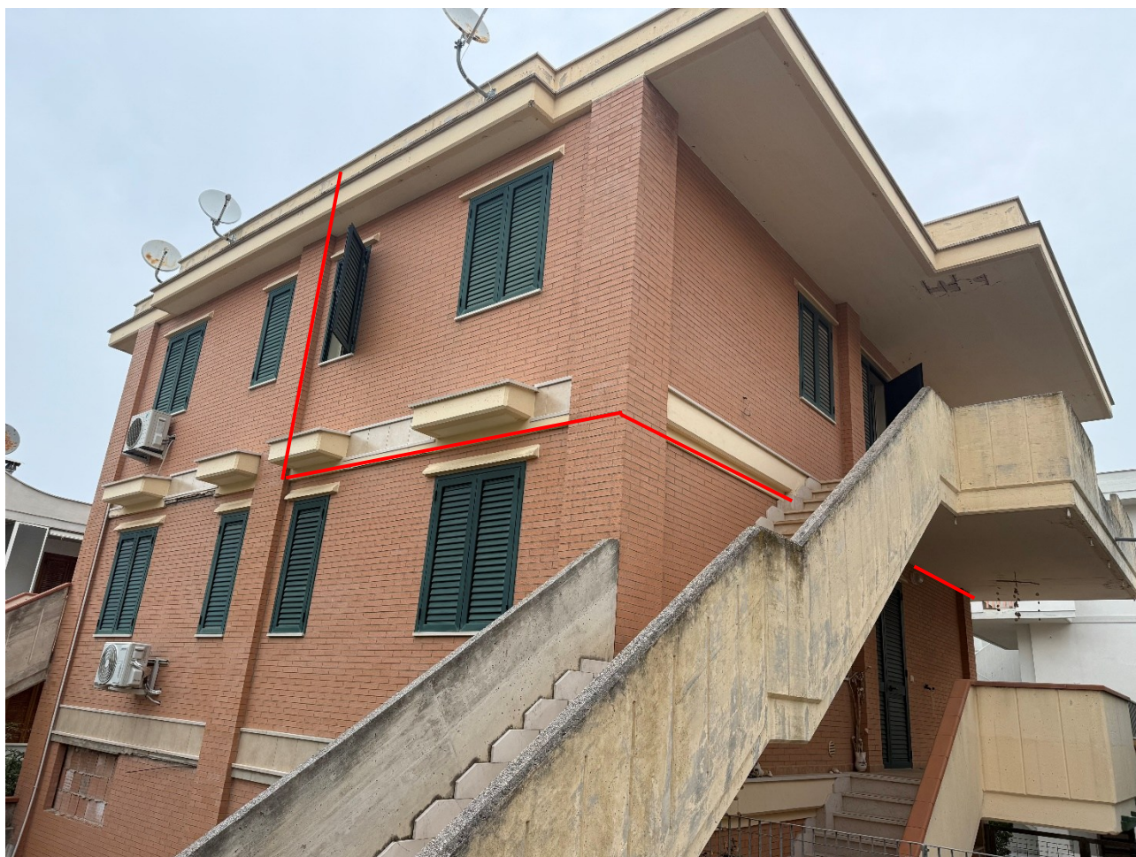
Foto 06 – Vista appartamento al piano secondo
