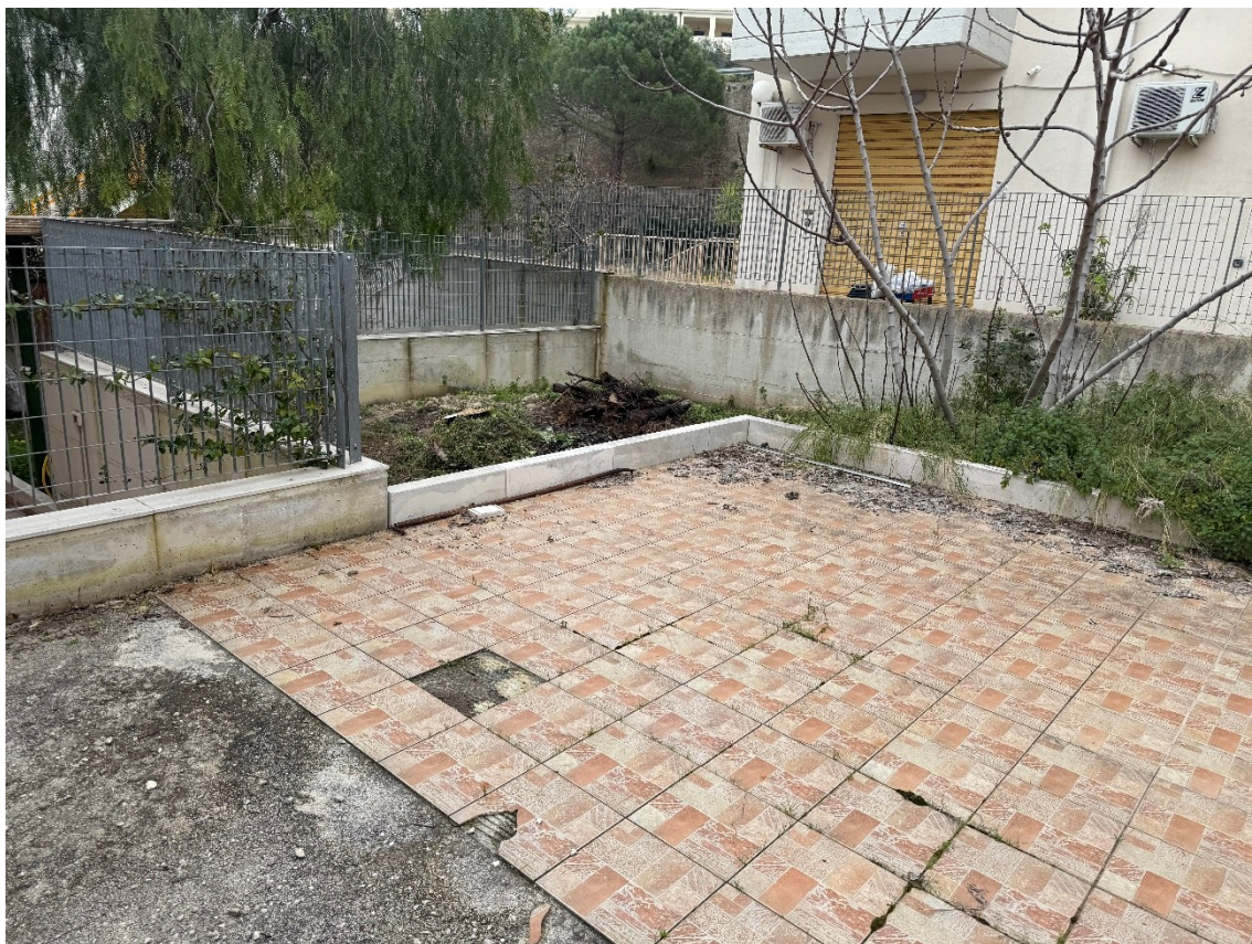
Foto 04 – Vista cortile piano terra
