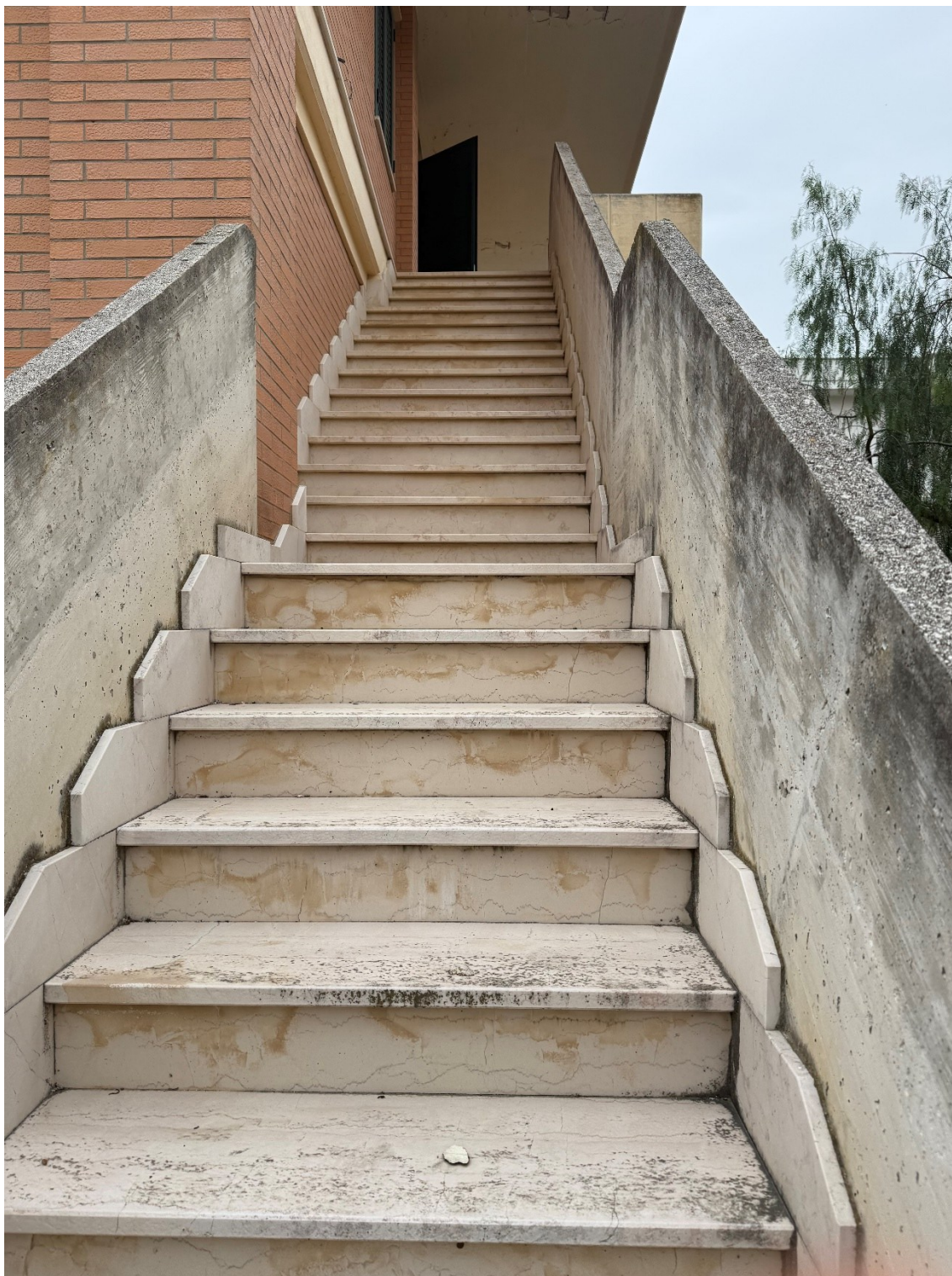
Foto 09 – Particolare scala esterna di accesso
