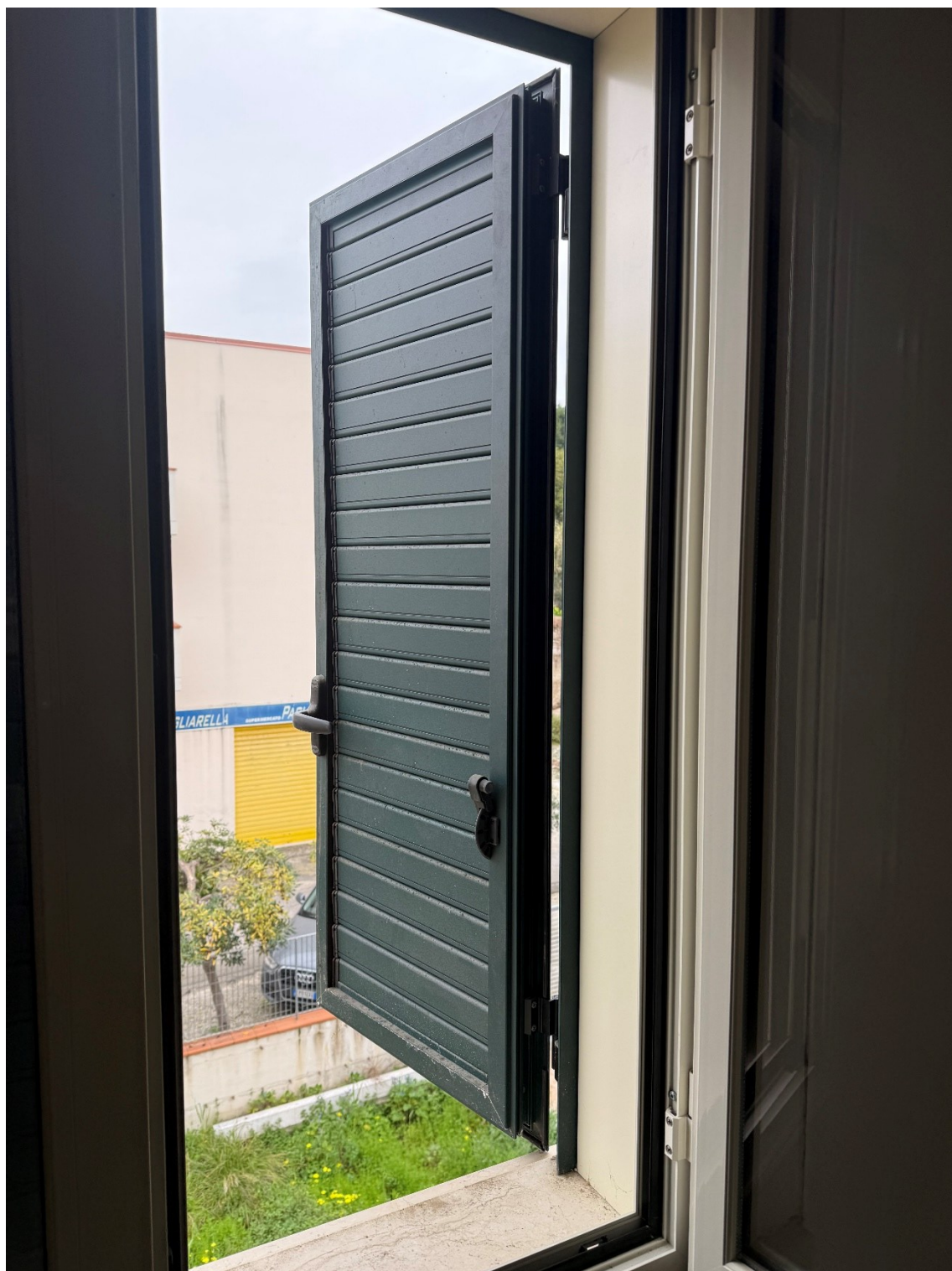
Foto 21 – Particolare infisso esterno
