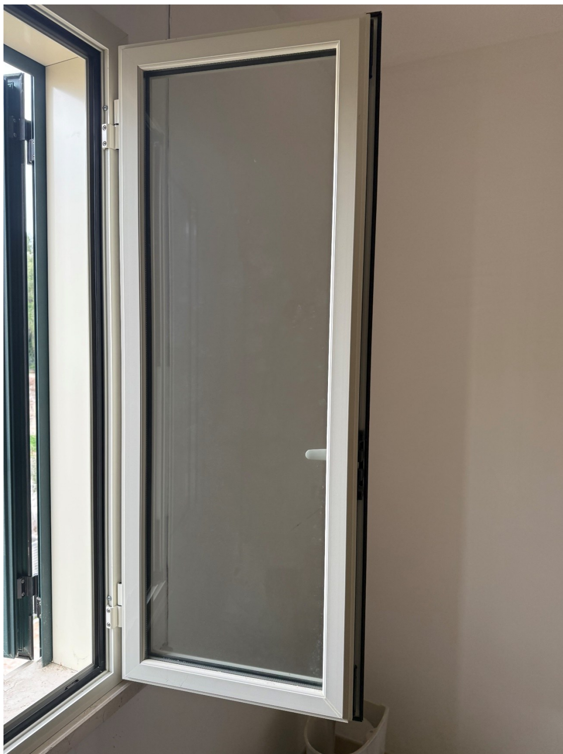
Foto 20 – Particolare infisso esterno
