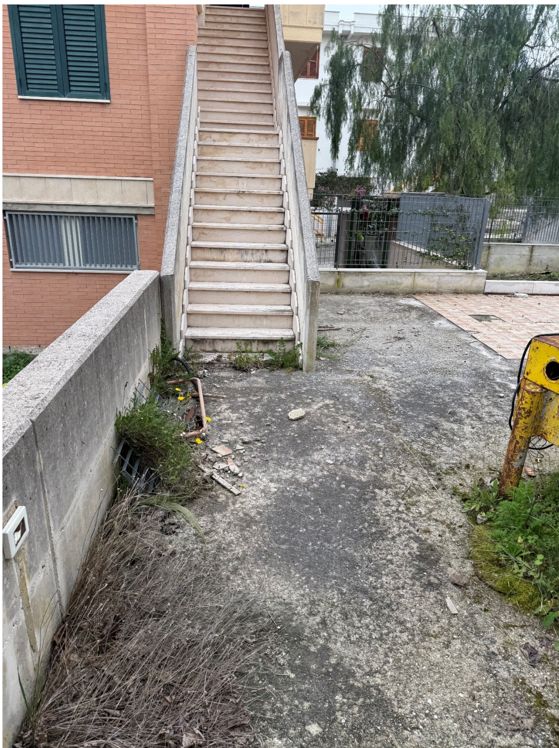
Foto 03 – Vista cortile e scala esterna di accesso
