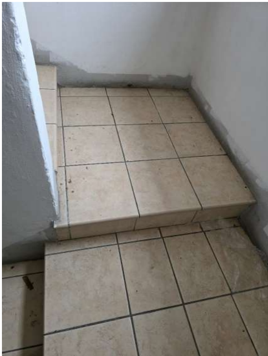
FOTO 5-6. vista scala di accesso -
