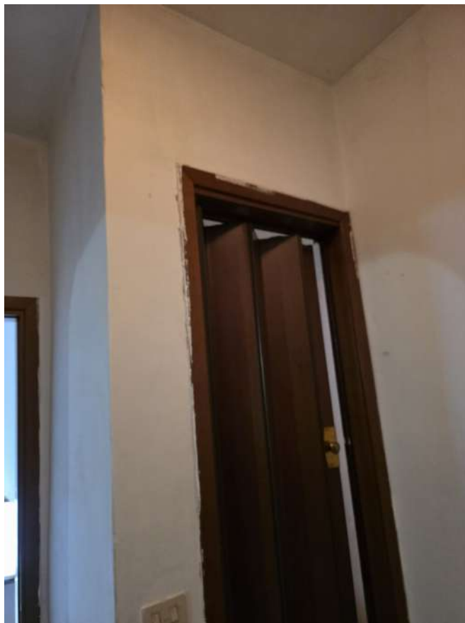
FOTO 22.. vista porta soffietto ripostiglio -
