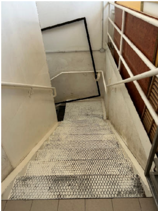
Scala accesso al piano seminterrato
