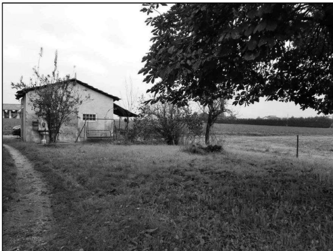
F 3 - Area di pertinenza e autorimessa
