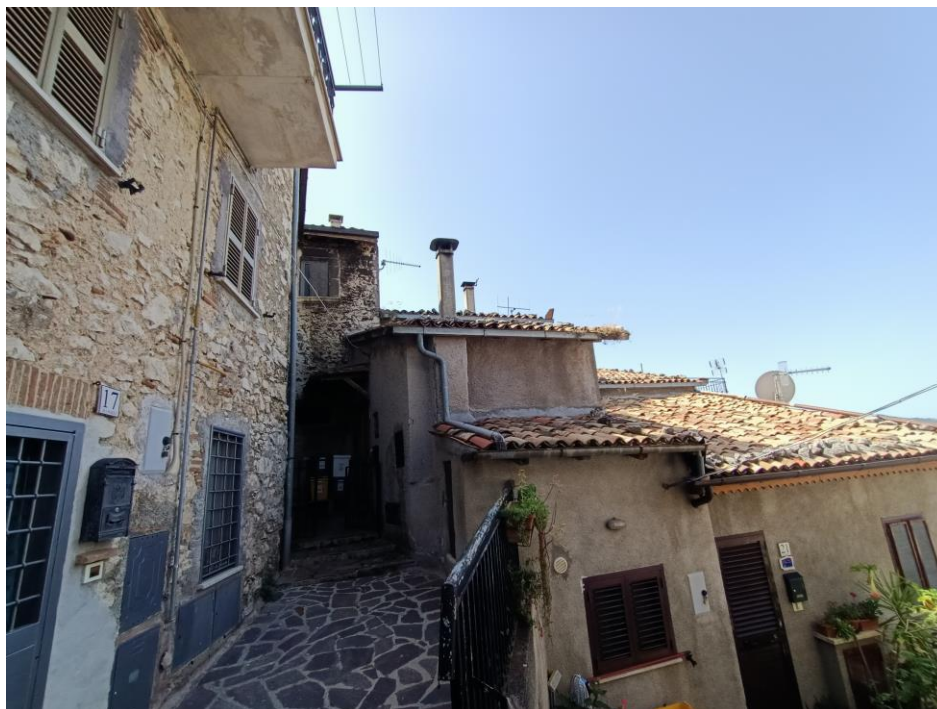
Foto 2 – Accesso unità immobiliare
