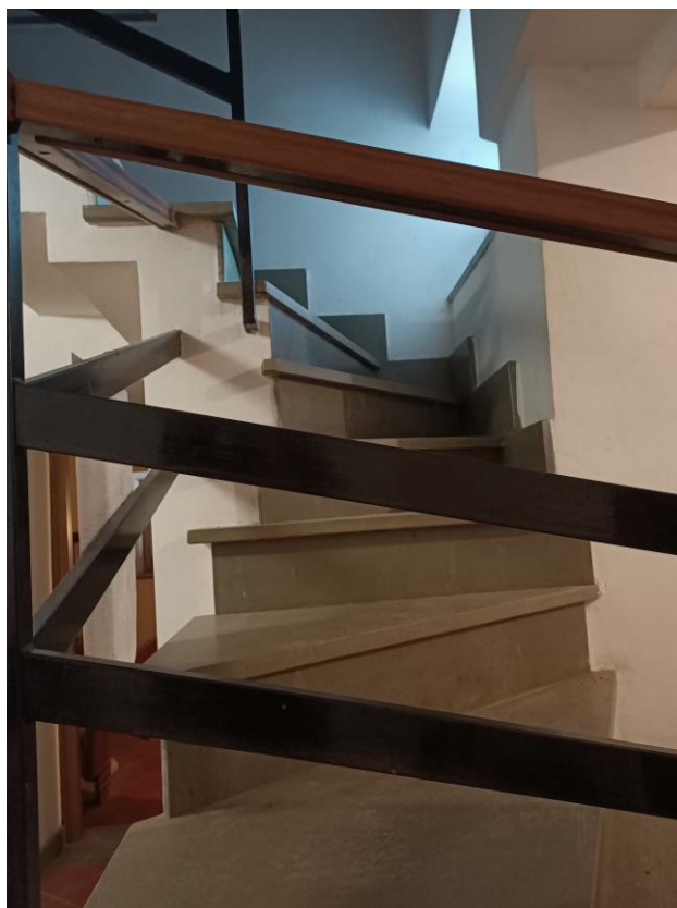
Foto 5– Piano Terra- Scala di accesso piano primo
