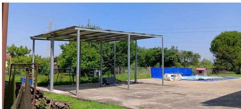
Foto 14: tettoia prevista in demolizione
