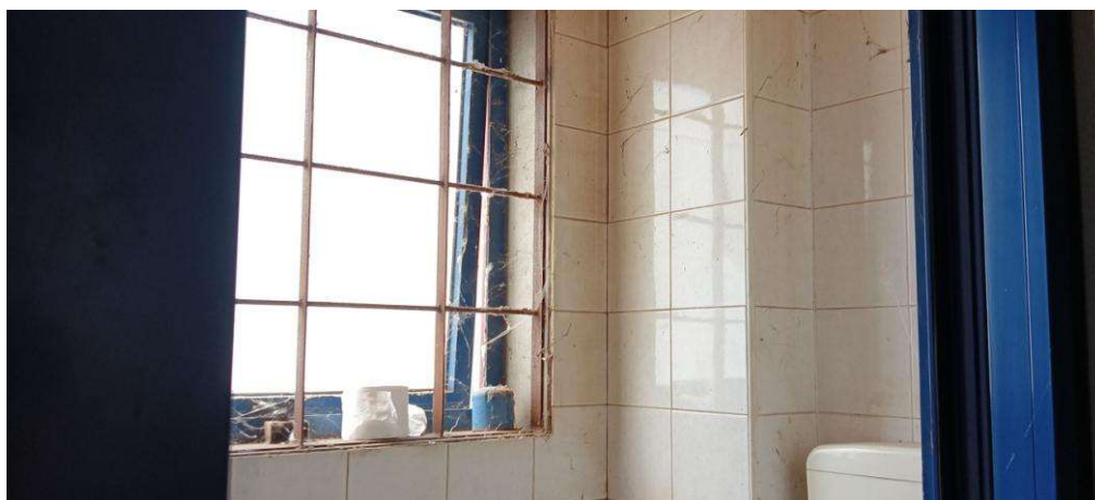
Foto 10: interno del fabbricato - bagno
