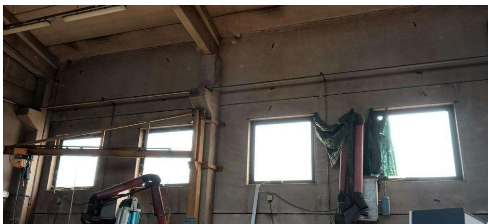
Foto 2: interno del fabbricato
