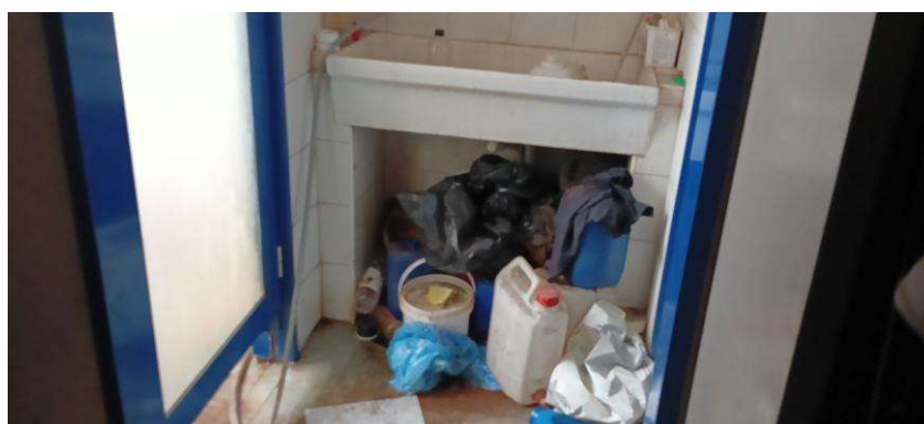
Foto 8: interno del fabbricato - bagno
