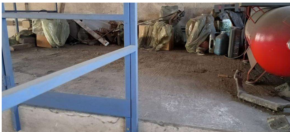
Foto 7: interno del fabbricato
