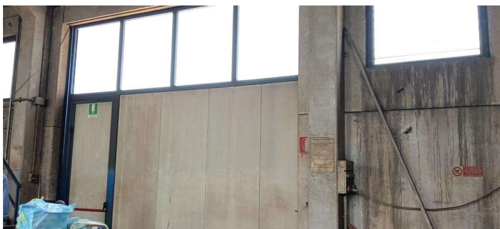
Foto 6: interno del fabbricato
