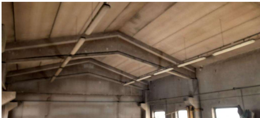
Foto 4: interno del fabbricato
